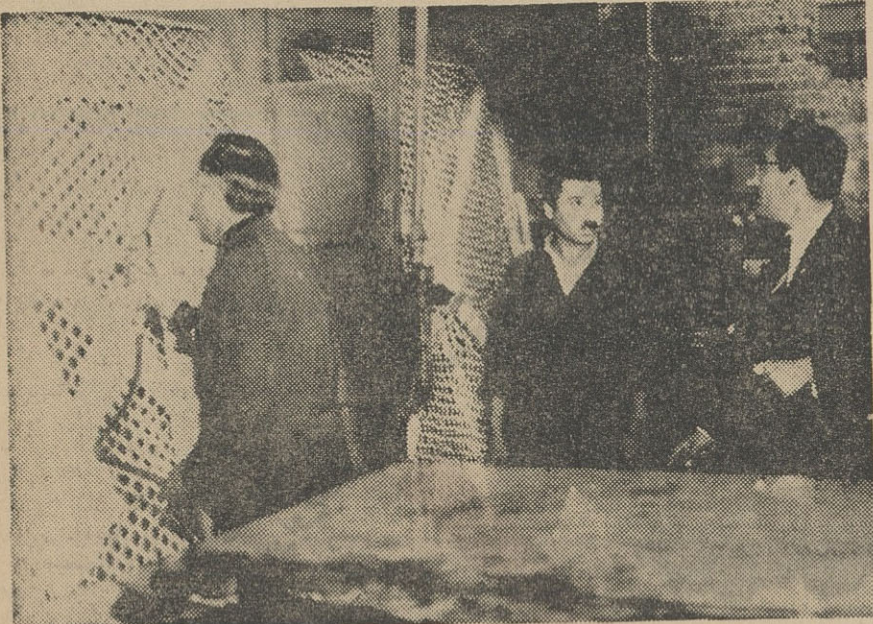
در کارخانه چرم سازی بادستگاه پمپ، چرم رنگ زده میشود و بعد از آنکه خشک شد، آماده بهره برداری می گردد.
