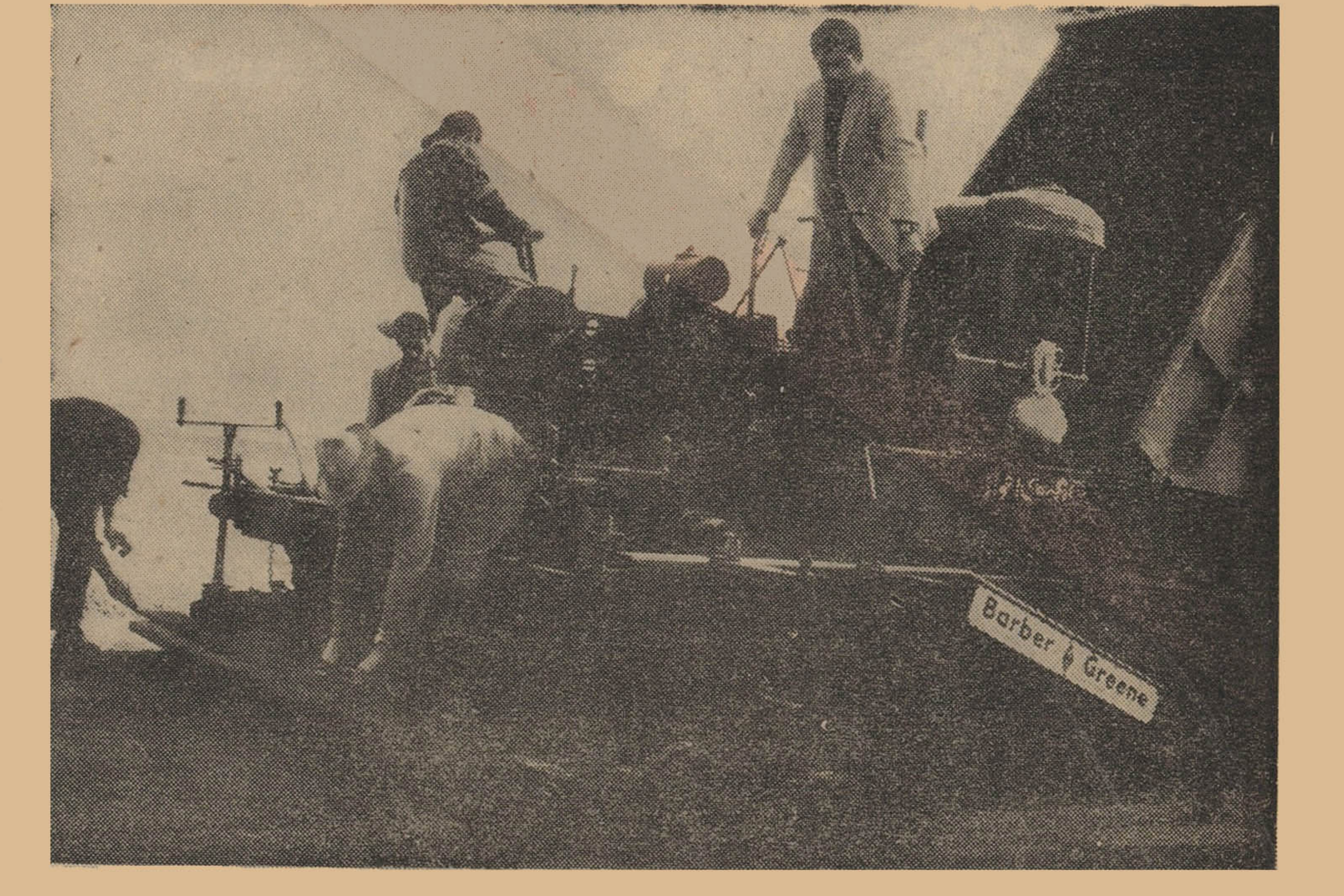
پس از زیر سازی کار اسفالت روی جاده سرعت انجام میگردد در عکس بالا گوشه ای از کار ماشین مخصوص صاف کردن اسفالت میباشد .
