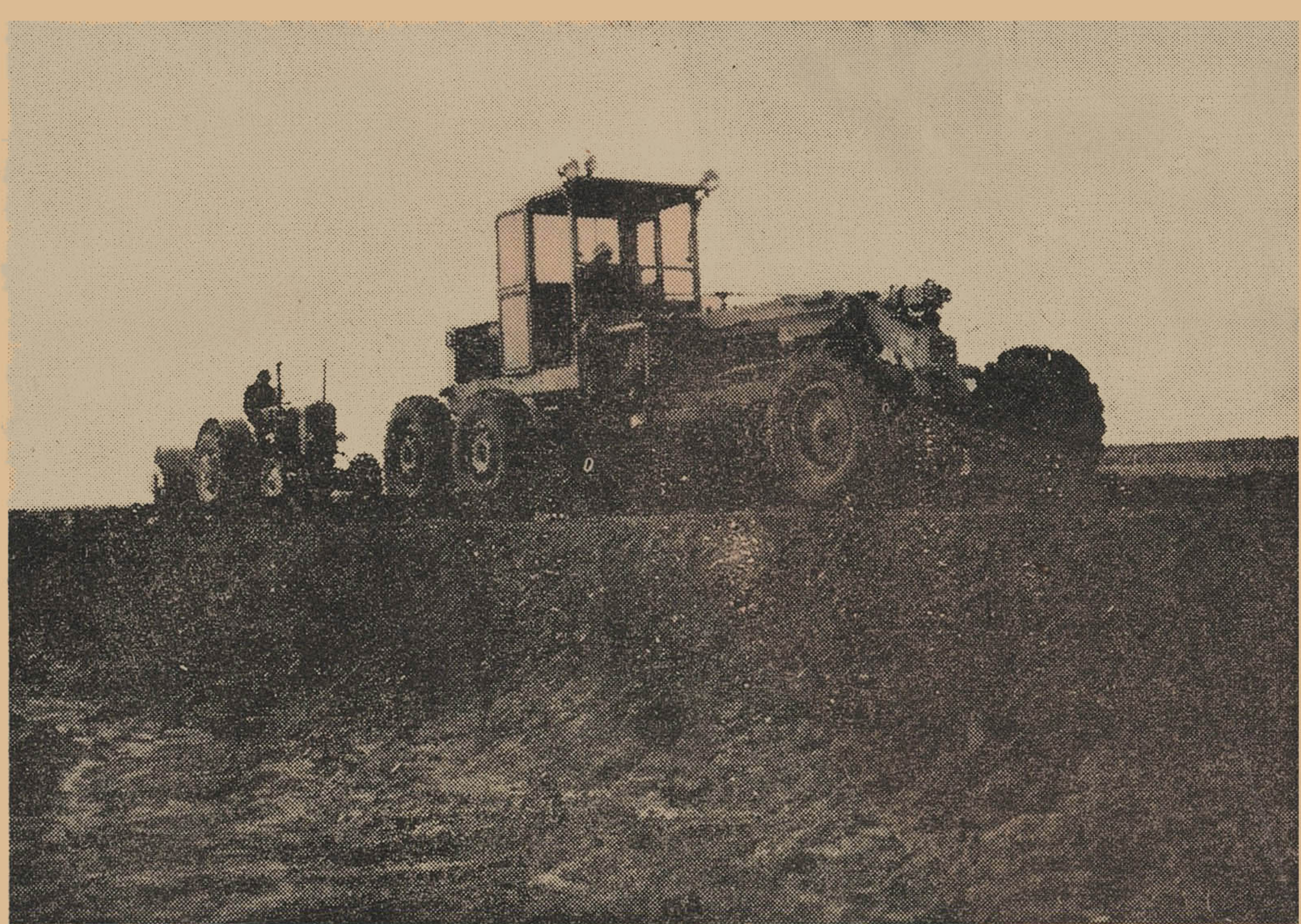
ماشین آلات شرکت گرانبیت بزرگترین و مجهزترین ماشین آلات است که برای اولین بار در امر ایجاد جاده سازی در ایران از آن استفاده میشود در عکس بالا یکی از ماشین های صاف کردن جاده هنگام کار دیده میشود .
