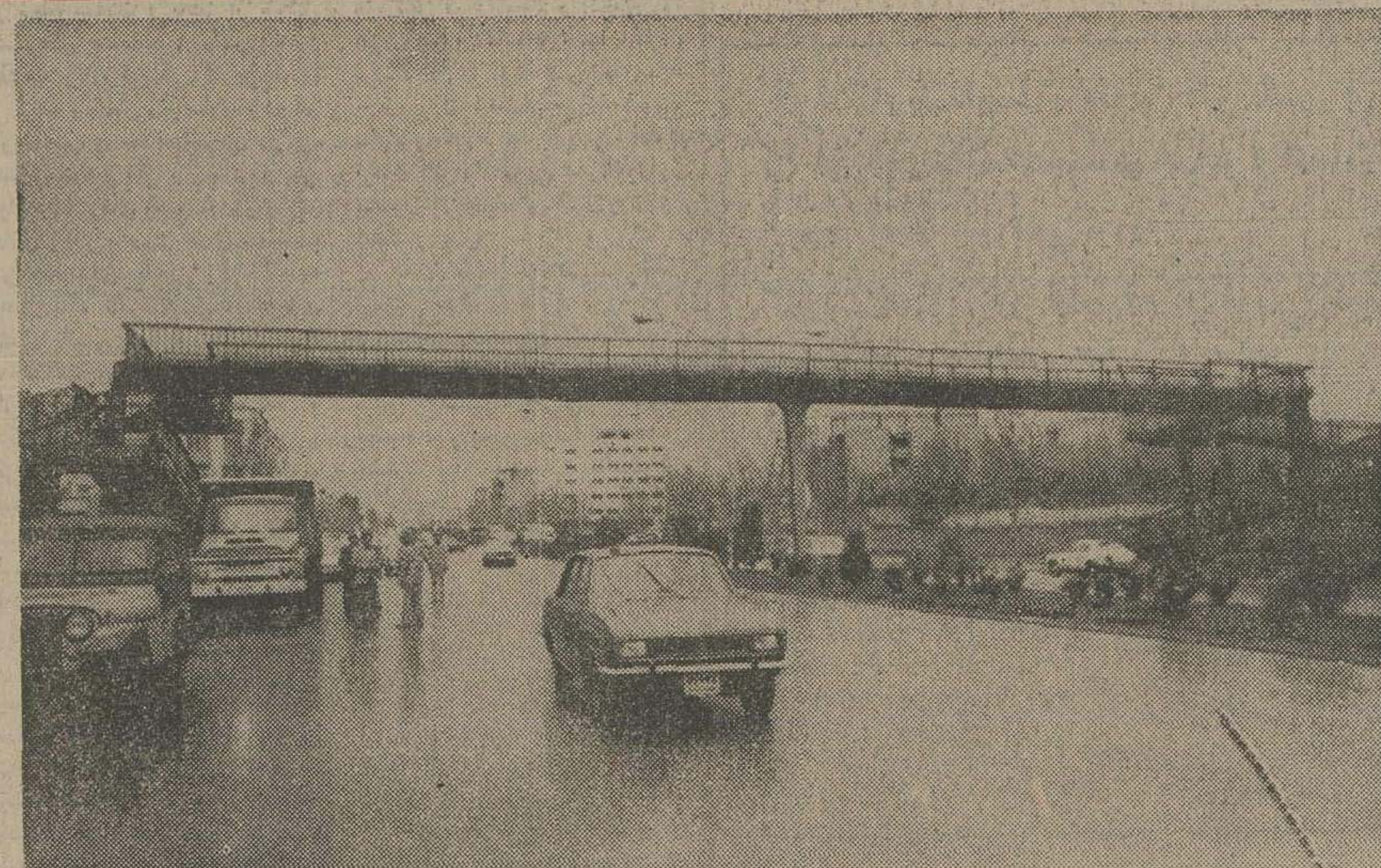
نخستین پل هوایی مخصوص عابر پیاده که در تقاطع خیابان دیستان با ۴۵ متری سیدخندان نصب شده است. قرار است تا پایان سال جاری نمونه‌های دیگری از این پل در خیابان‌های پرجمعیت تهران نصب شود.
