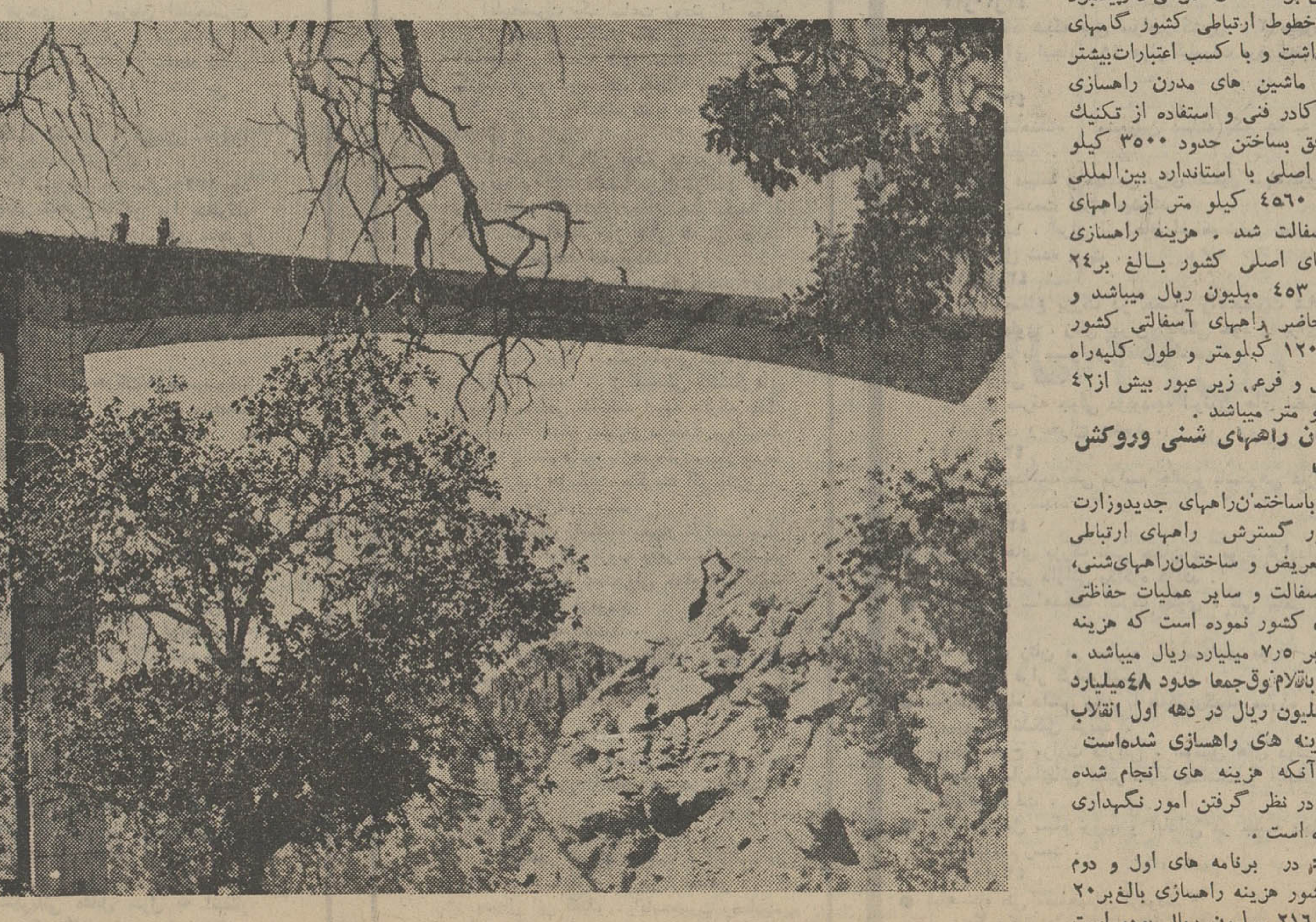
پل دال که روی راه اسفالتی شیراز - کازرون ساخته شده است . دهانه این پل ۱۰۹ متر است
