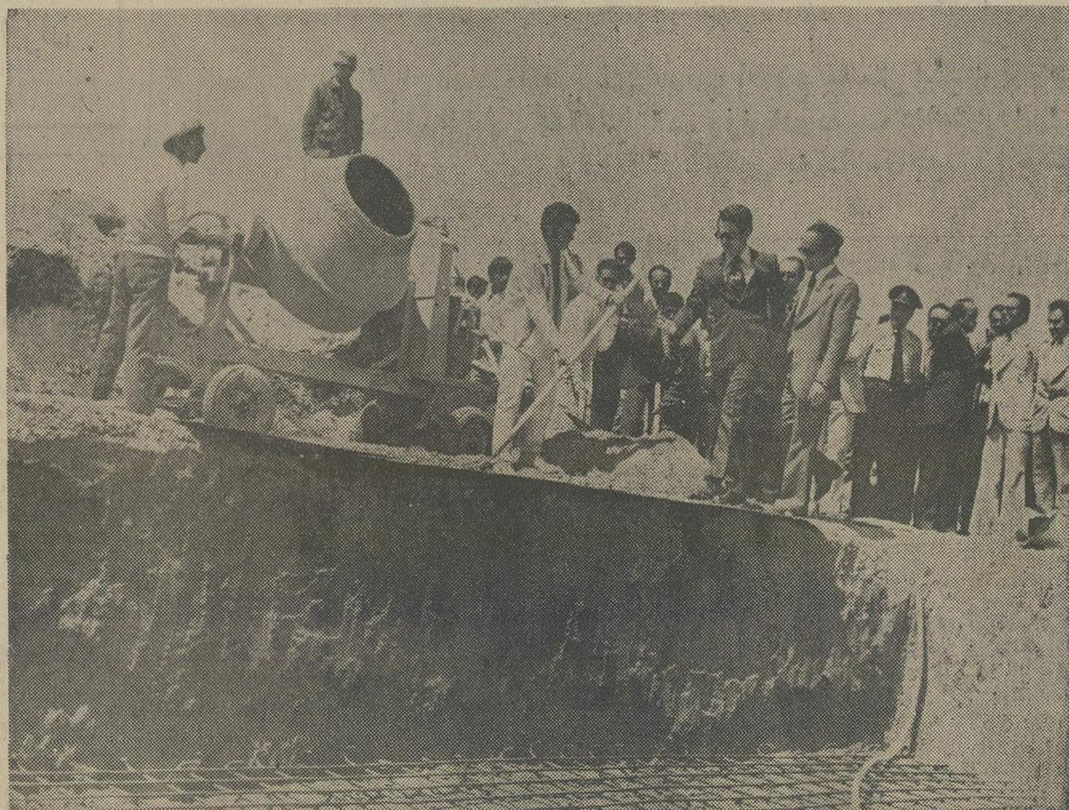
آقای مهندس عطاءالله معتدل استاندار استان چهار محال و بختیاری بنام نامی شاهنشاه آریامهر باریختن بپتون اجازه شروع عملیات ساختمانی برنامه عظیم خانه سازی را در این استان صادر کرد
