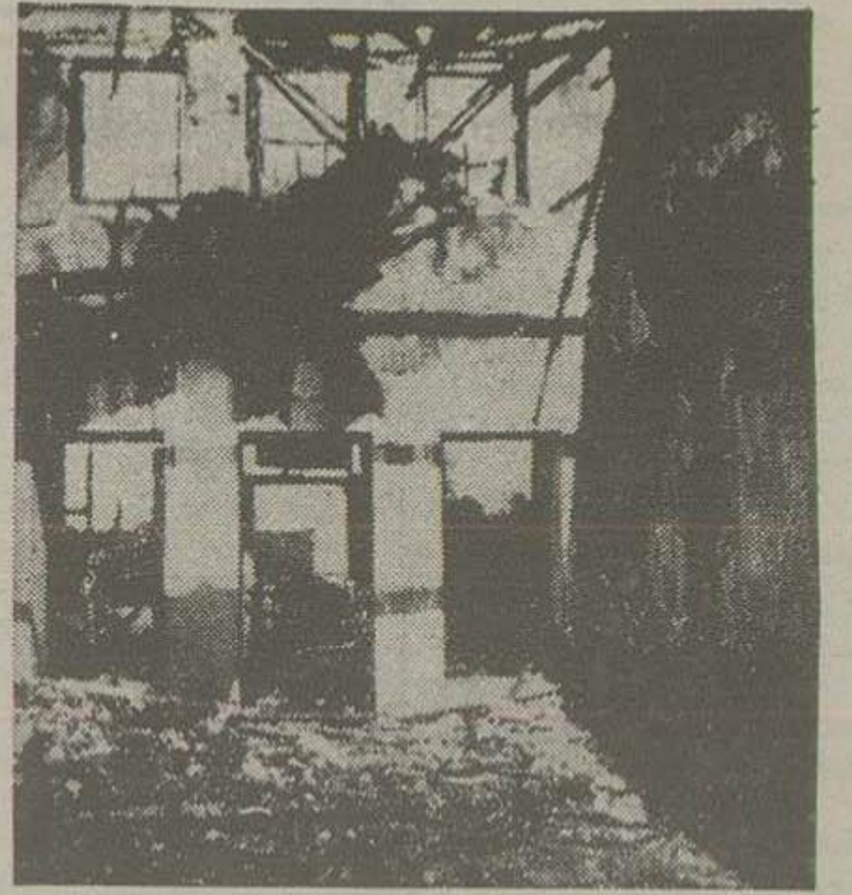
منظره‌ای از آسایش بعد از اطفاء حریق
