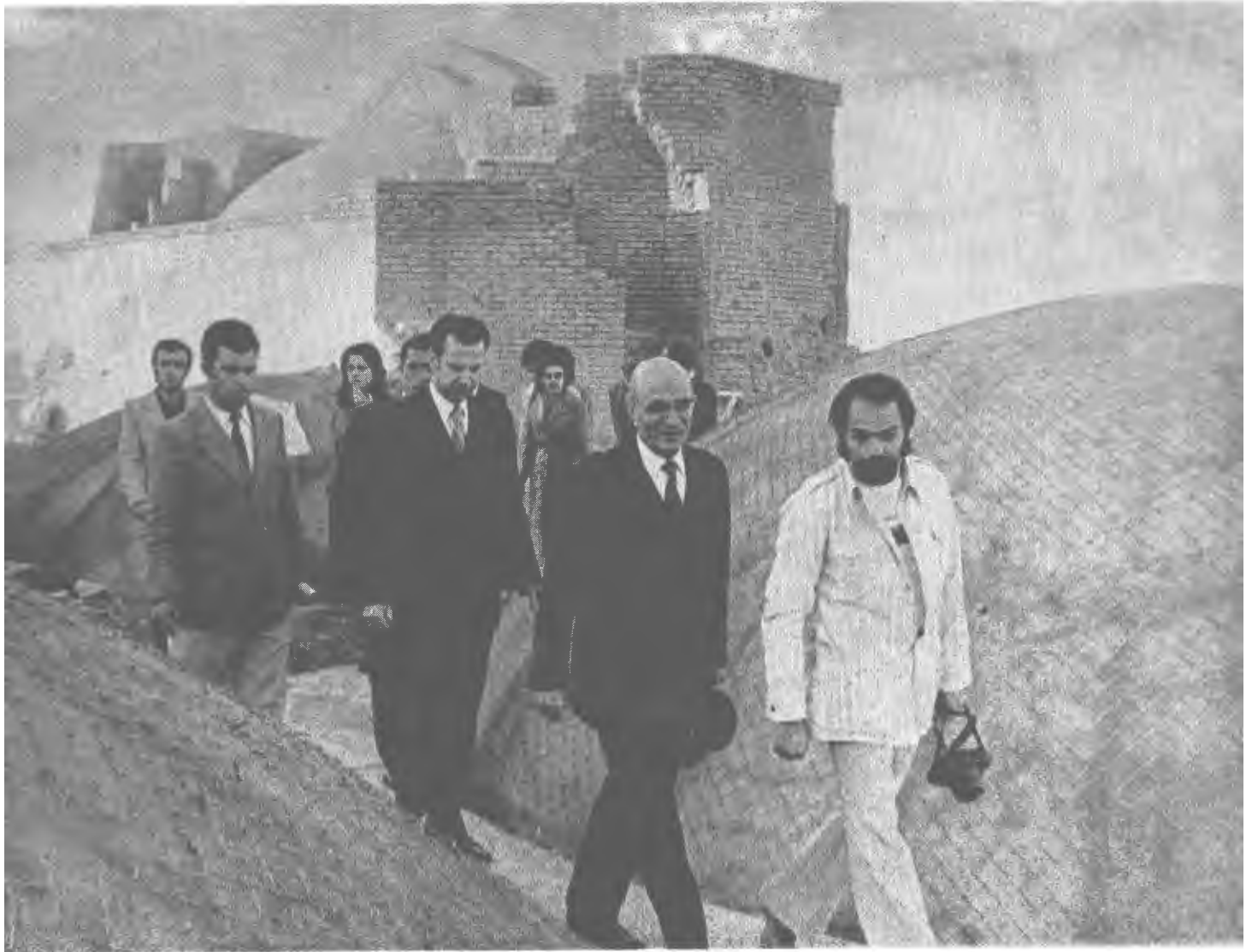
بازدید جناب آقای استاندار آذربایجان شرقی از تعمیرات مسجد کبود
