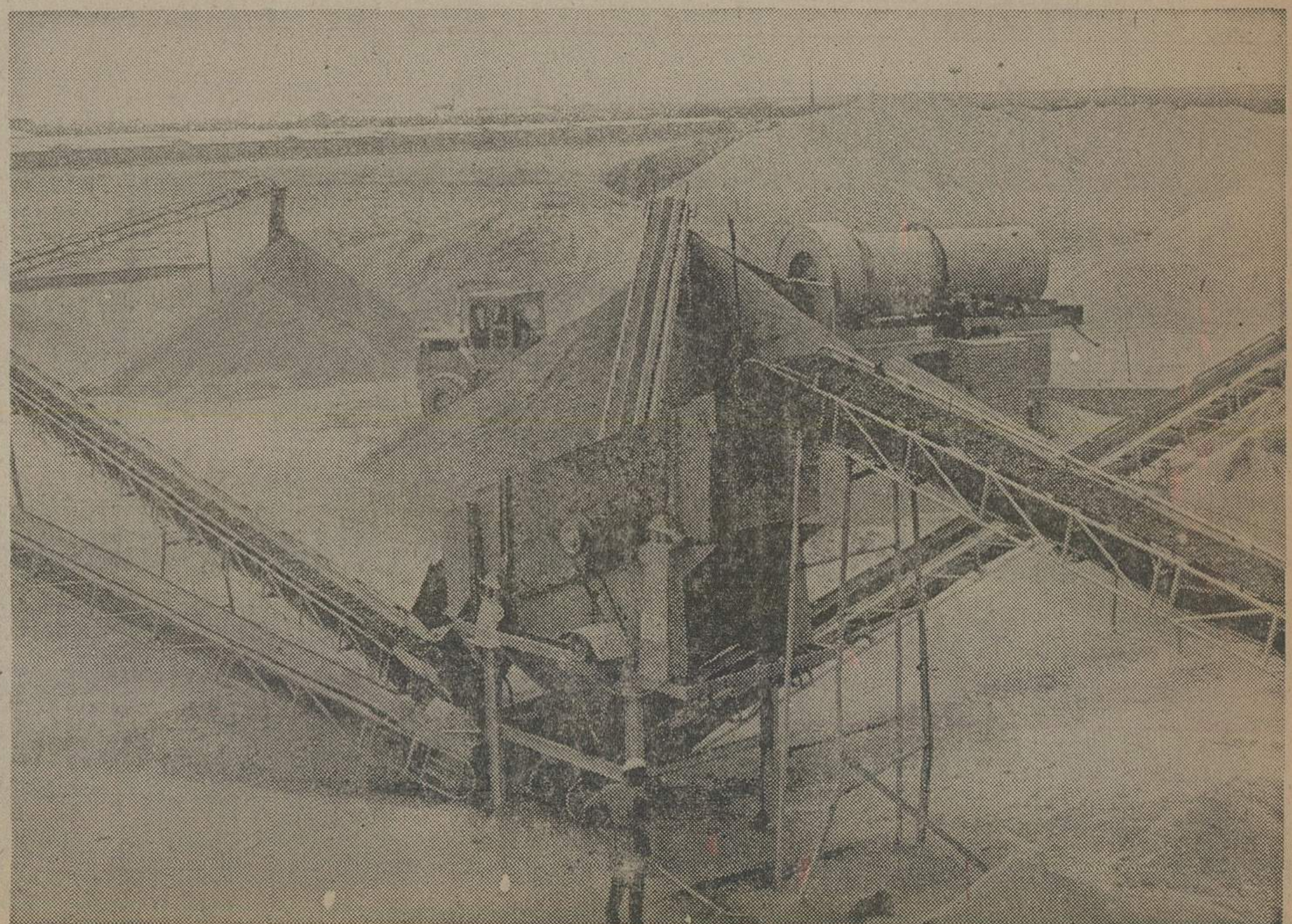
مصالح سنگی برای آسفالت ریزی مطابق با آخرین اصول فنی تهیه و بکارگاهها حمل میشود.
