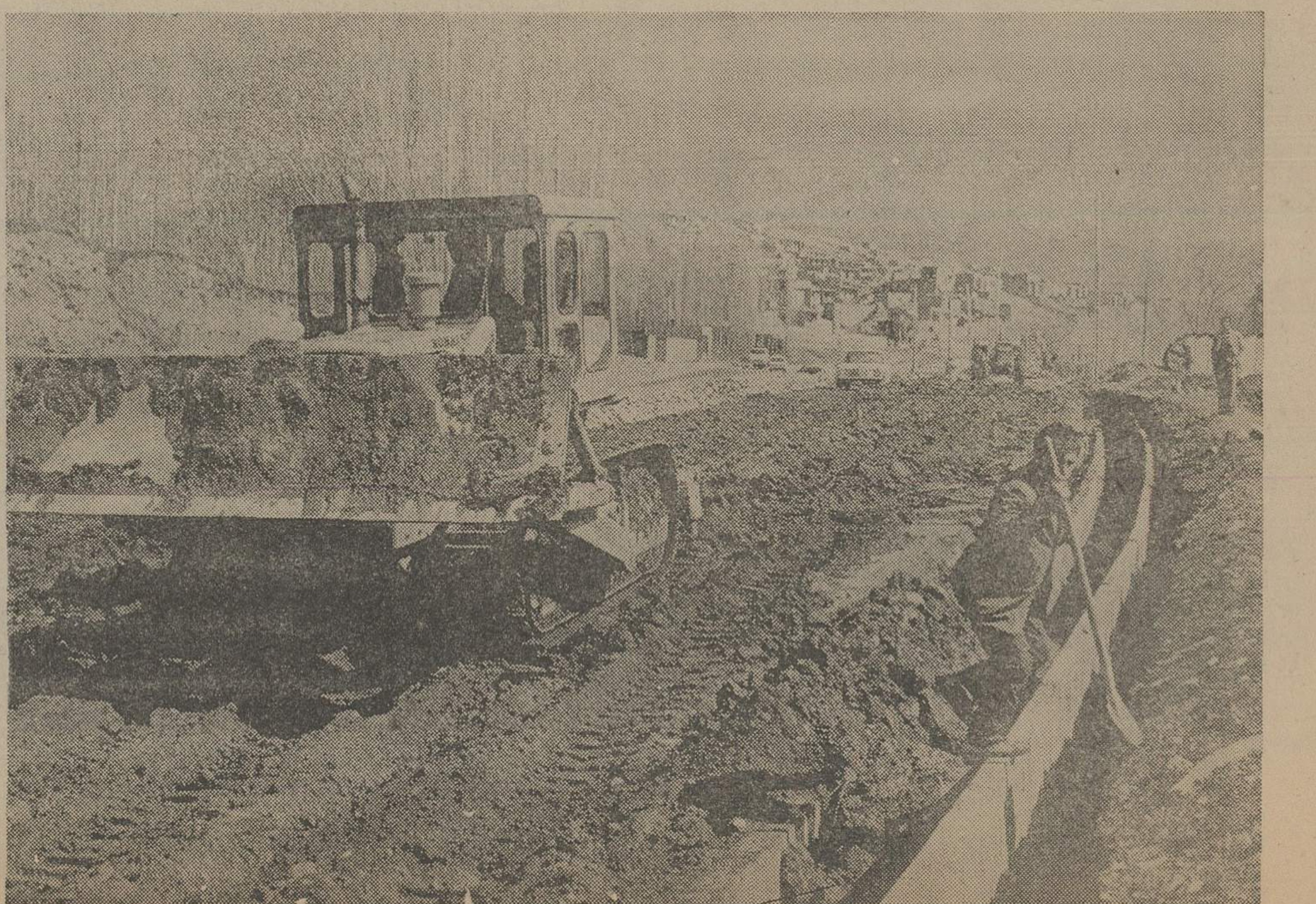
علا خاکبرداری ، بندی نوع این خاک بود که بخاطر جلوگیری از مشکلات آبی تا زیر به برداشتن آن گردیدیم
