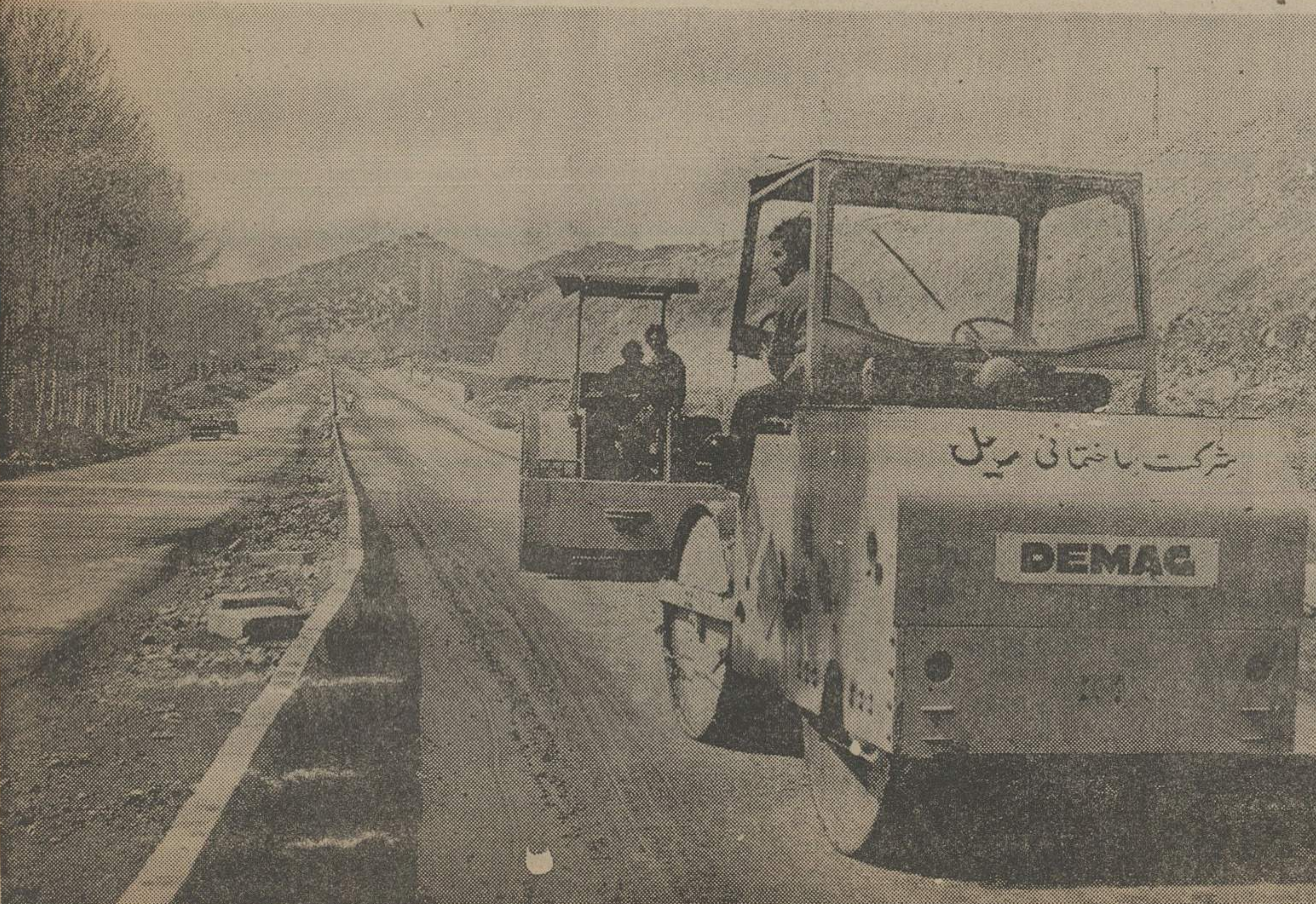
کلیه خاکهای این منطقه جهت احداث بلوار بخاطر نامرغوبی آن برداشته و بجای آن از بهترین نوع خاک دانه بندی ریخته شد تا مقاومت بیشتری داشته و مسالها قابل استفاده باشد .
