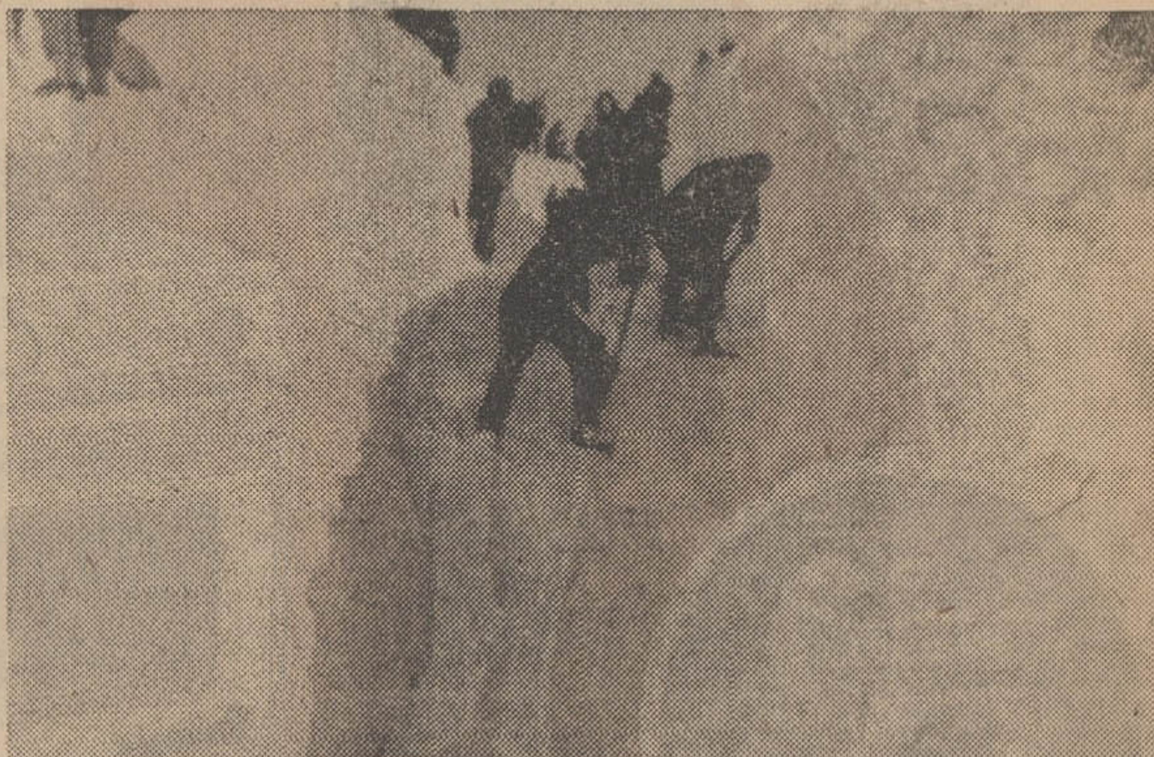
دوره تهران - قم ماموران تونلهای برفی احداث می‌کردند تا راه برای عبور قطارها باز شود . در یک قسمت از این راه ارتفاع دیواره‌های برفی به ۸ متر می‌رسید .
