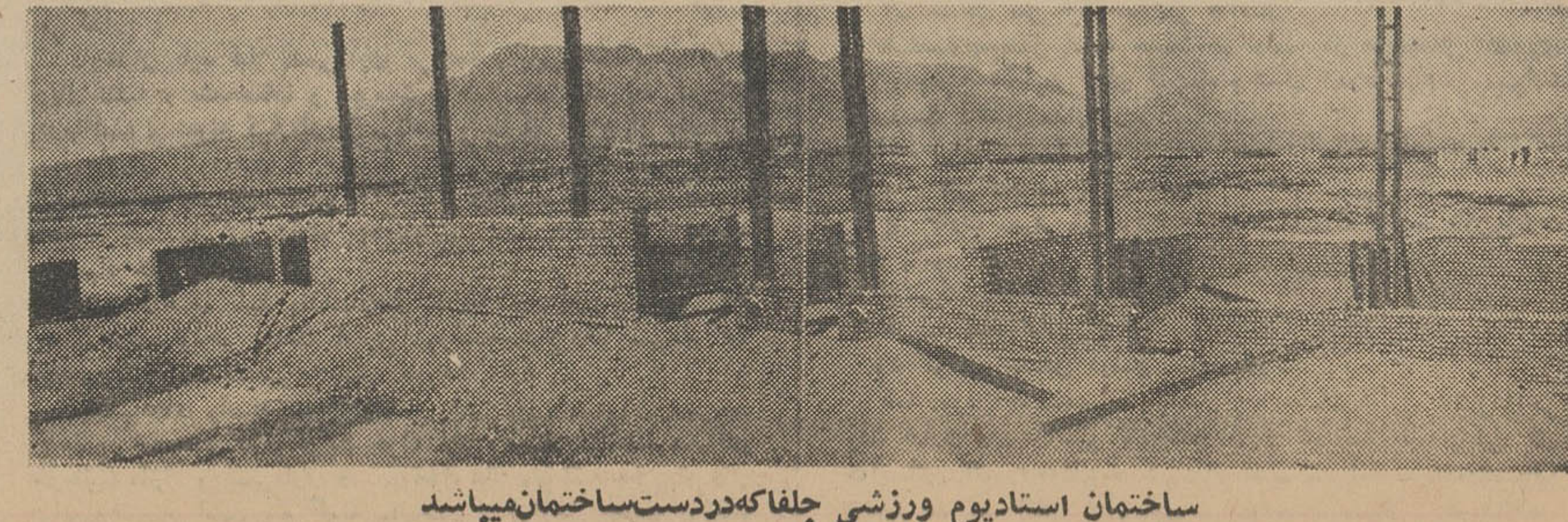
ساختمان استادبوم ورزشي جلفا كه در دست ساختمان ميباشد
