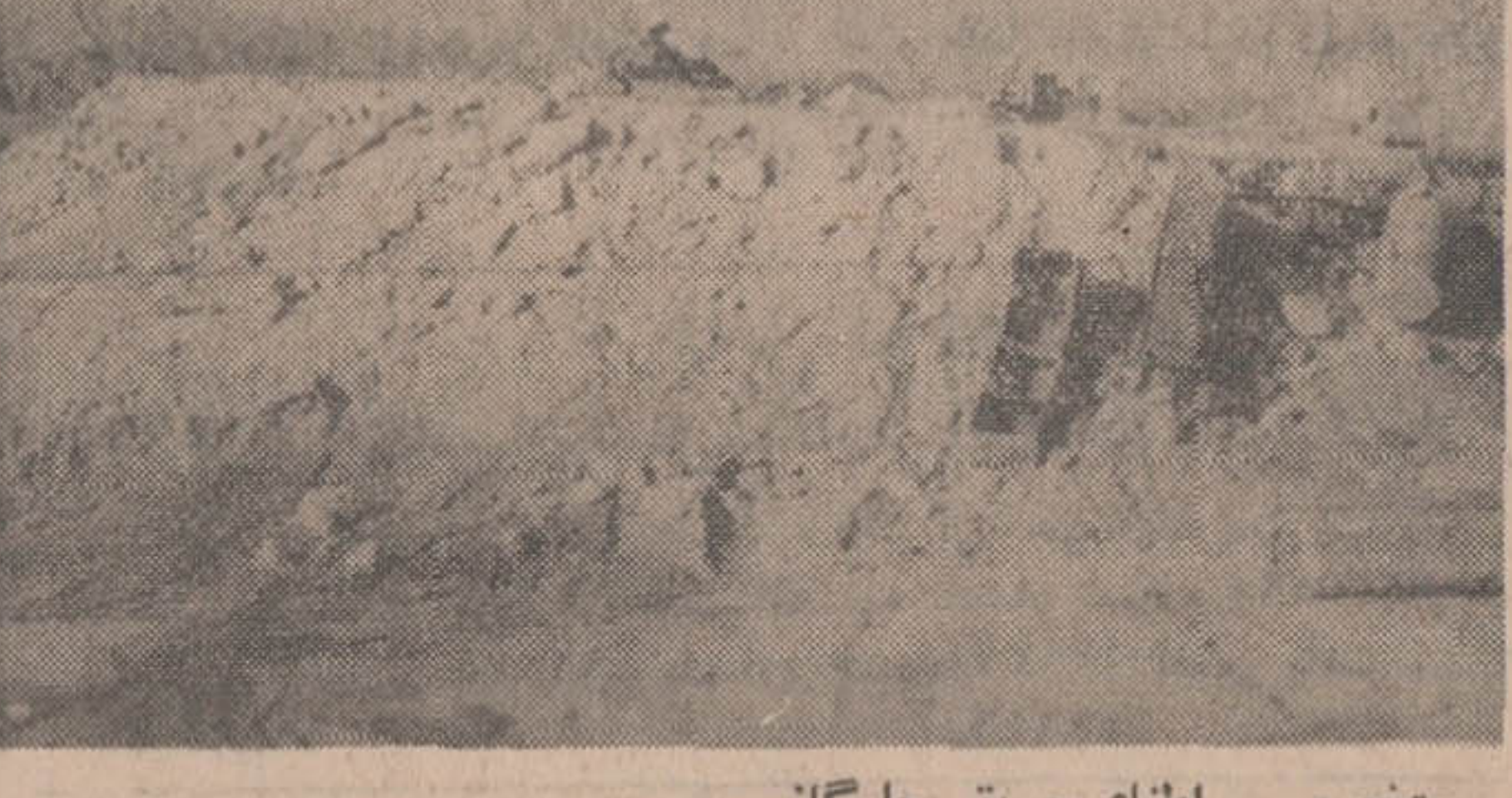
منتهی حریق چاه گاز ۳۱۱ مسجد سلیمان، قبل از آنکه چاه را بکلی مهار کنند چندان آب آلوده را خاموش کردند ولی چون گاز سموم کننده از دهانه آن متصاعد میشد آنرا دوباره آتش زدند. این عکس هنگامی گرفته شده که شعله های چاه خاموش شده بود ولی گاز از دهانه آن بارقاع چند متر متصاعد میشد.
