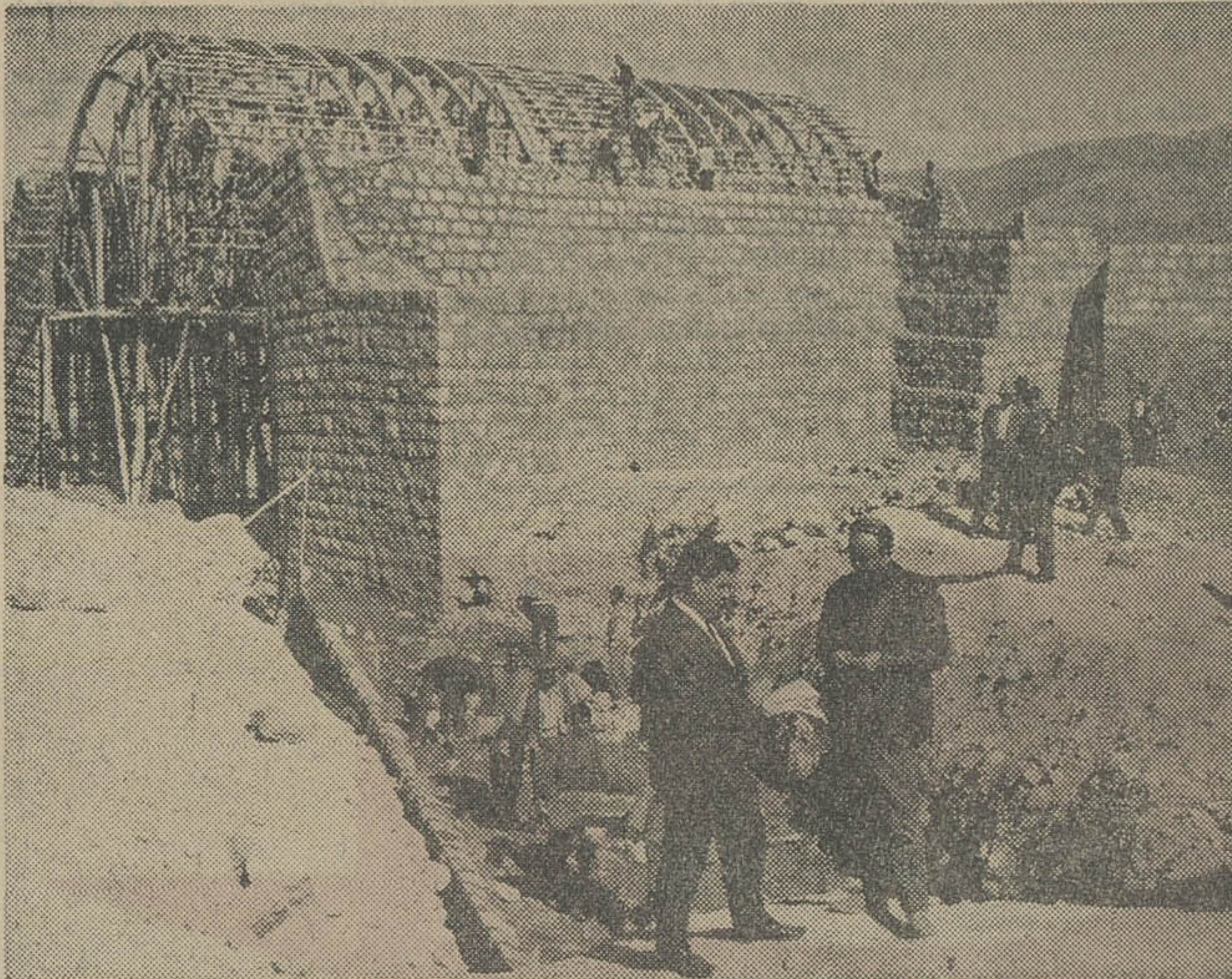
در این راه بزرگترین پل ۷ دهانه ۳۰ متری با ۱۴ متر ارتفاع در دست ساختن مشاهده میشود
