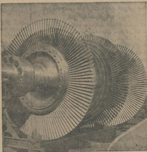
توربینهای بخار و گاز مرکز نیرو را کامل میکند.
