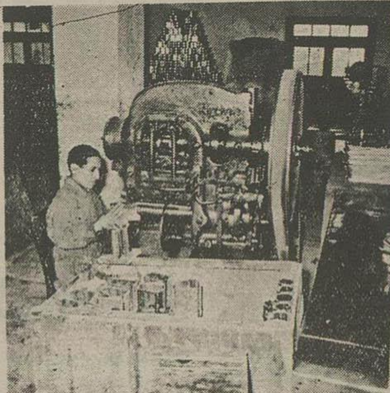
دستگاههای عظیم پرس از جمله تأسیساتی است که بمنظور تهیه ظروف مختلف لعابی بکار میرود
