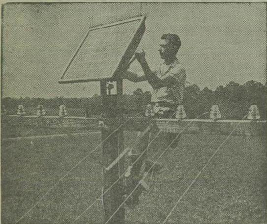
نیویورک - یکی از کارگران شرکت تلفن باطری خورشیدی را که از طرف شرکت تلفن بل امریکا تهیه شده روی یک تیر تلفن نصب میکنند. این باطری که از اختراعات لابراتوارهای شرکت تلفن بل میباشد با استفاده از نور خورشید برق تولید میکند. الکتریکه ای که بدین طریق تولید میگردد بصرف ارتباطات تلفنی در سفحات جنوبی امریکا میرسد.
