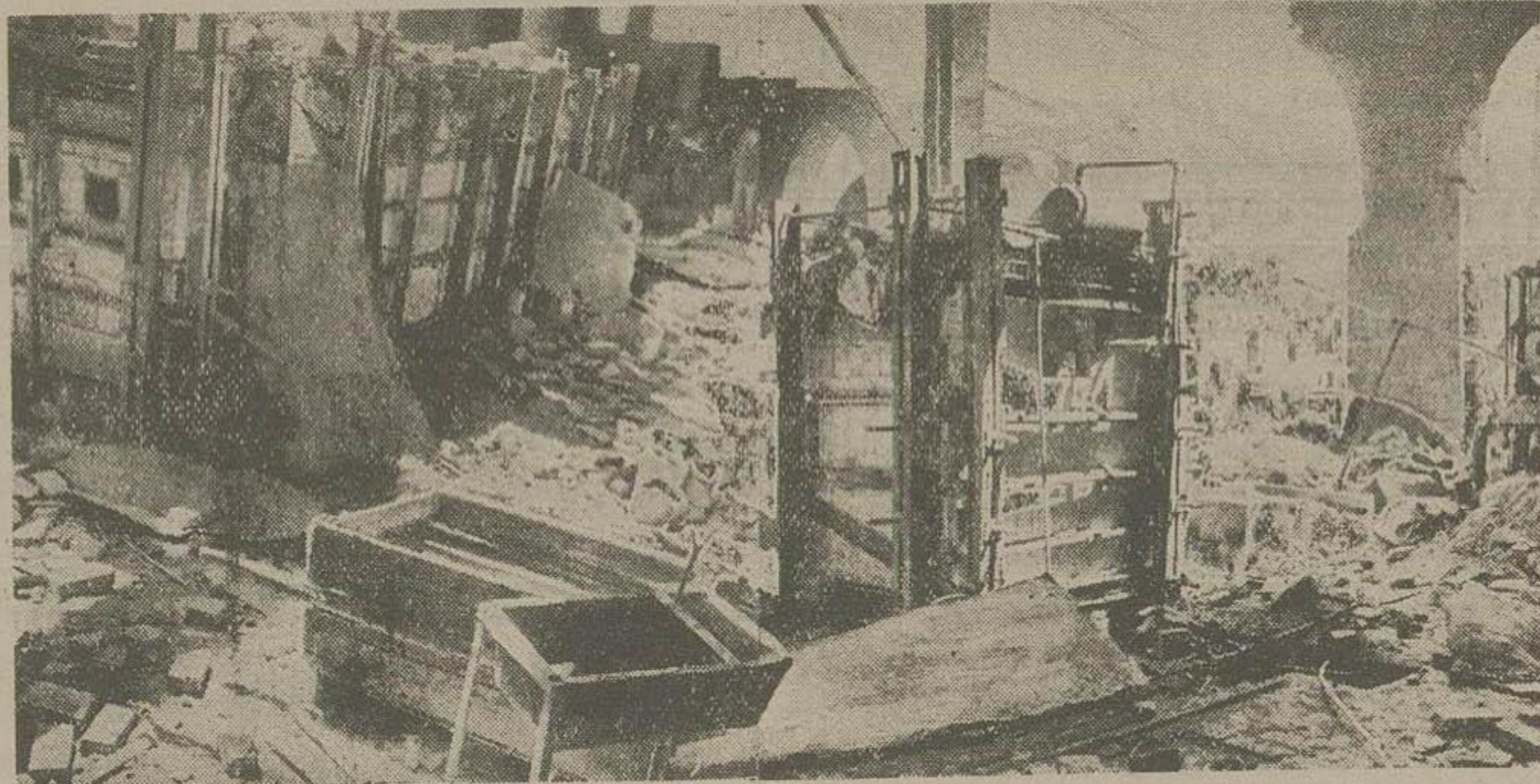
در این عکس گوشه ای از محوطه کارخانه در حالیکه سقف آن خراب شده و از وسط کوره محتوی شیشه مذاب و از طرف دیگر بقایای دیک بخار وجود دارد دیده میشود.
