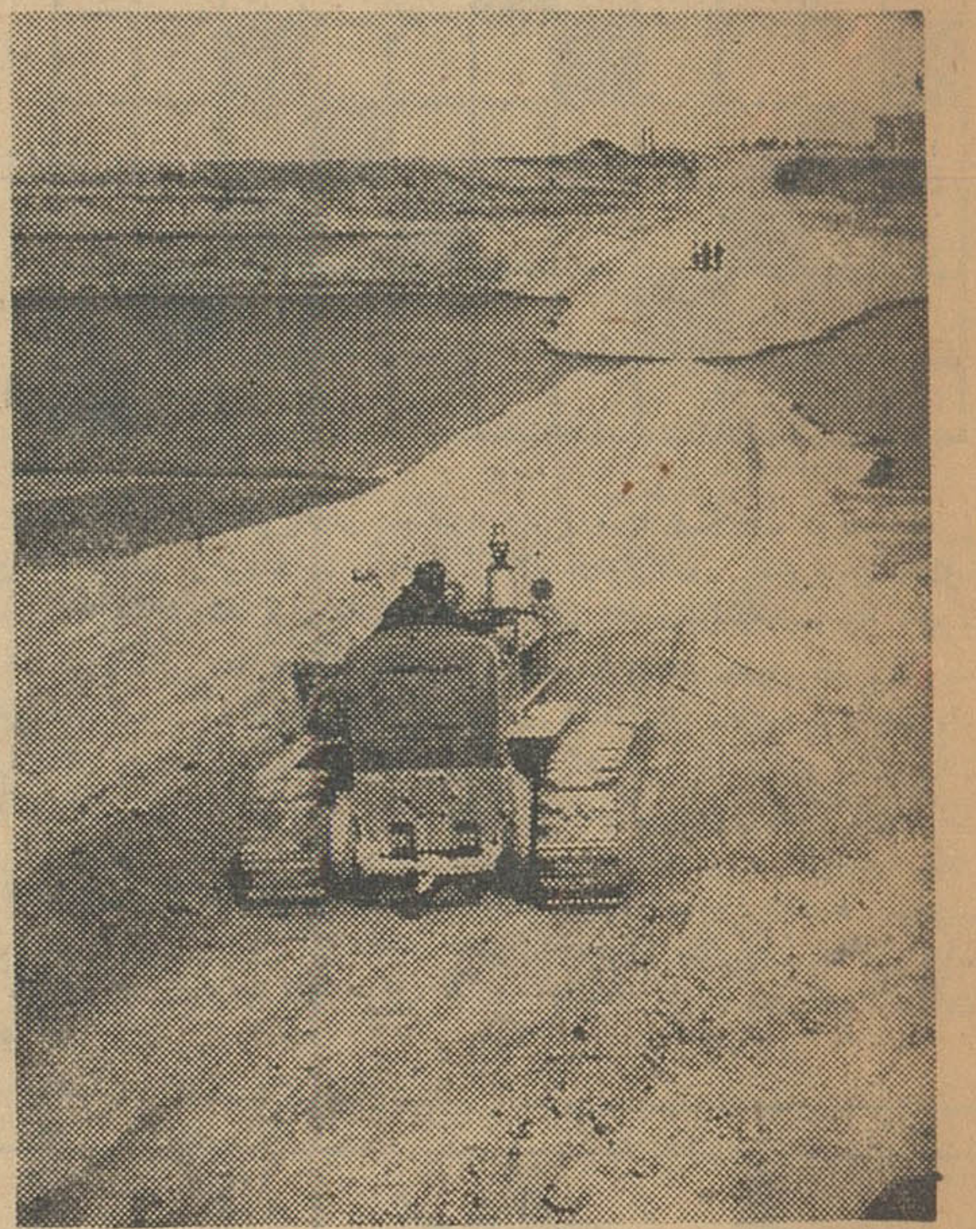
در عکس بالا بولدور مشغول خاکبرداری از محل ساختمان پل میباشد
