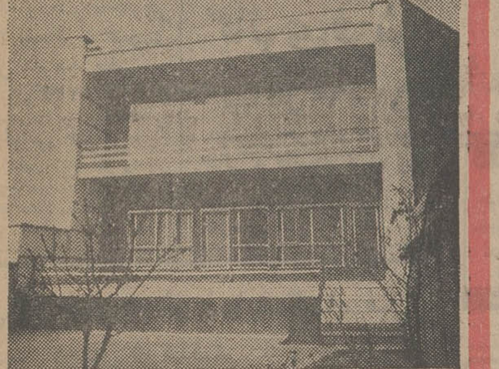
خانه شماره ۴ تاج، خیابان شاد مهر، کوی هوشنگ، شماره ۴۴
