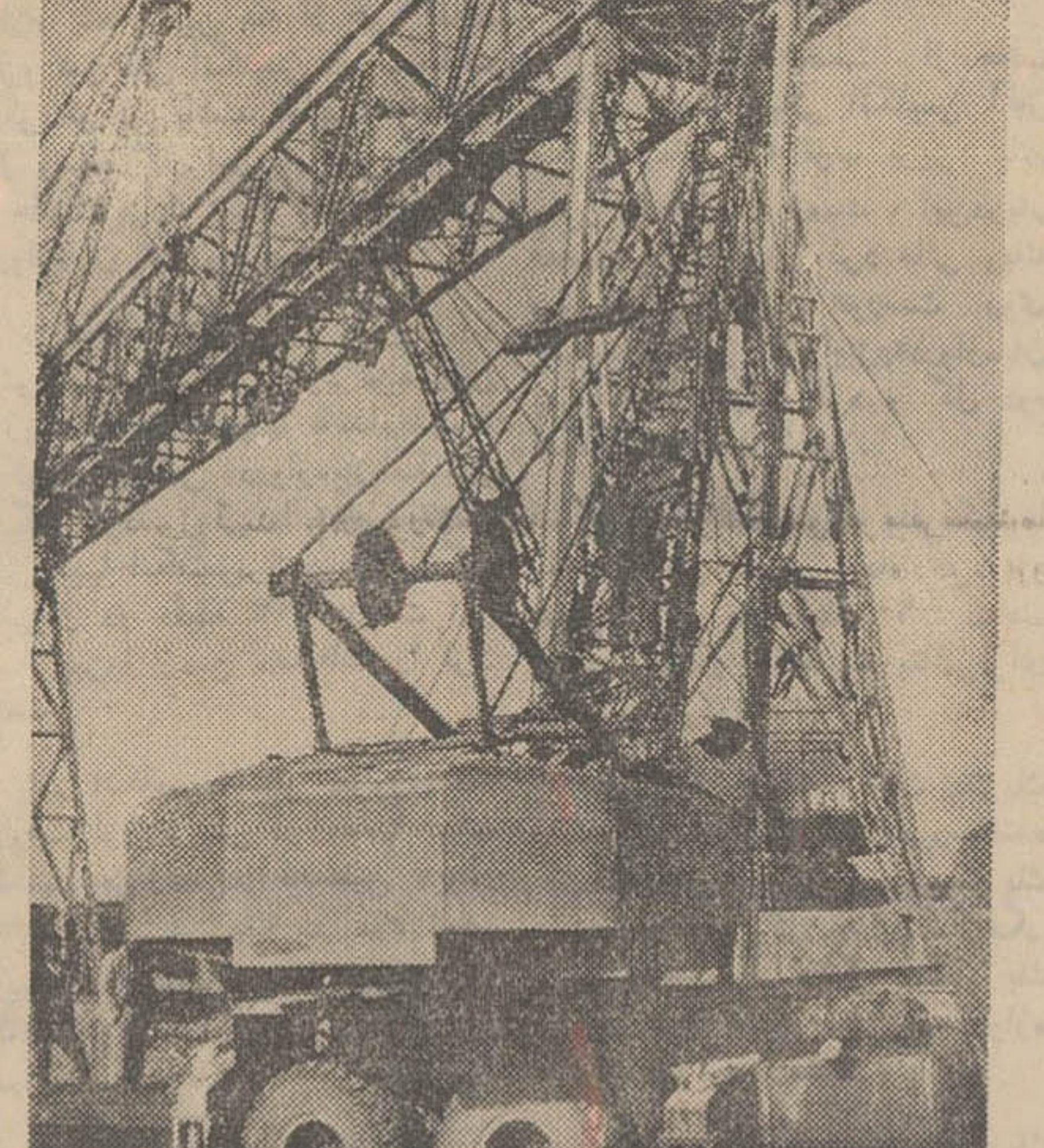
جر ثقیل غول آسا در ایستگاه راه آهن جلفا نصب شد.
