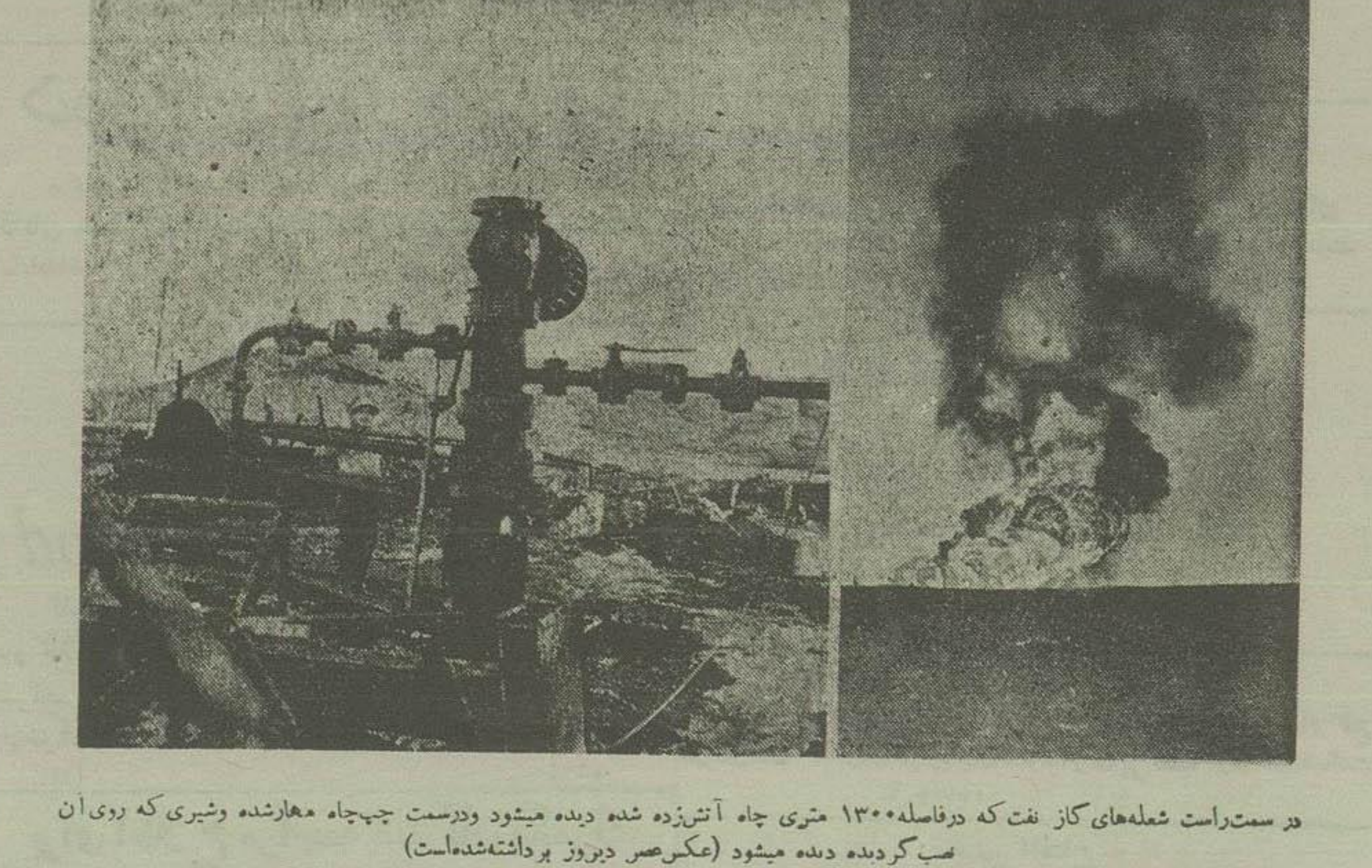
در سمت راست شعله‌های گاز نفت که در فاصله ۱۳۰۰ متری چاه آتش زده شده دیده میشود و در سمت چپ چاه مهار شده و شیری که روی آن صب کرده دیده میشود (عکس صبر دیروز برداشته شده است)
