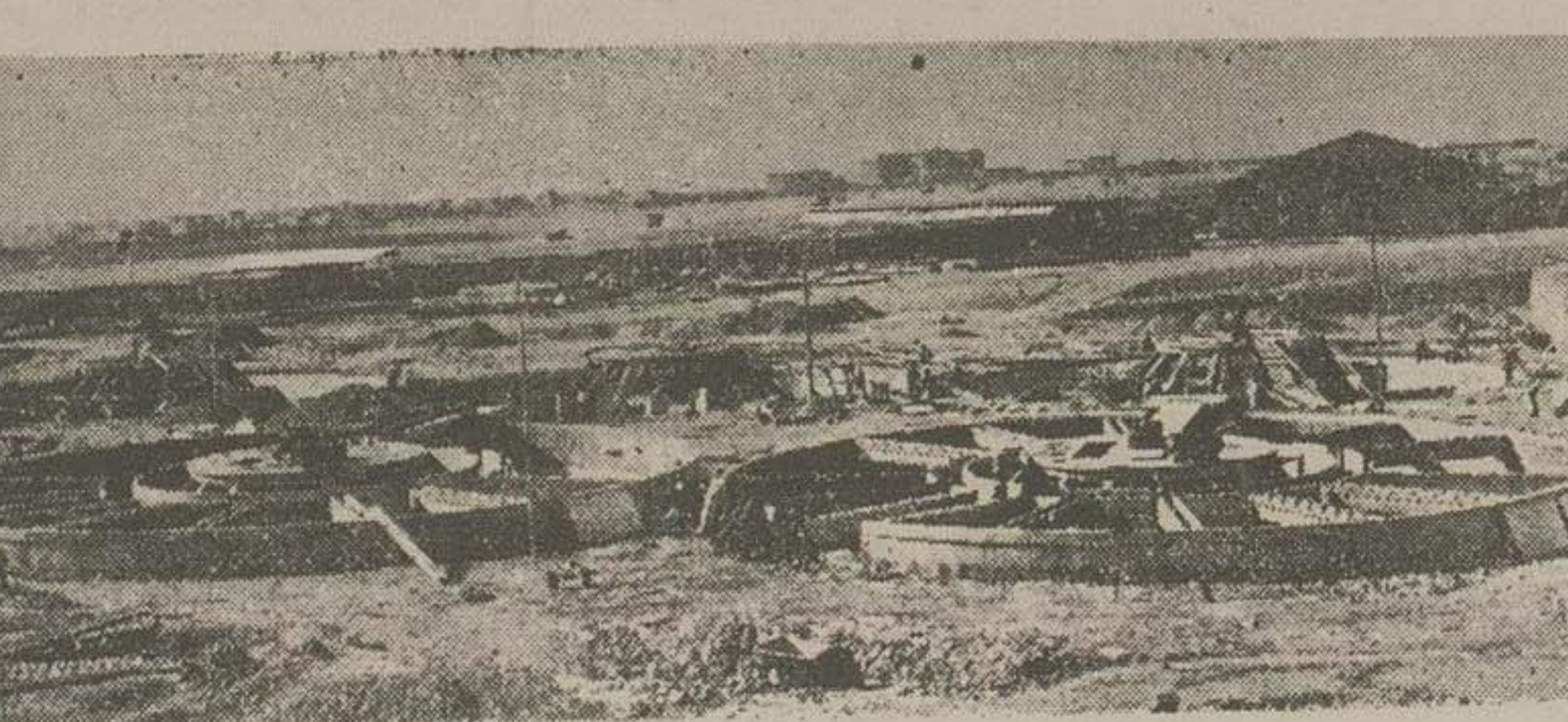
در عکس بالا قسمتی از صفیخانه لوله کشی آب تهران که در شرف اتمام میباشد دیده میشود
