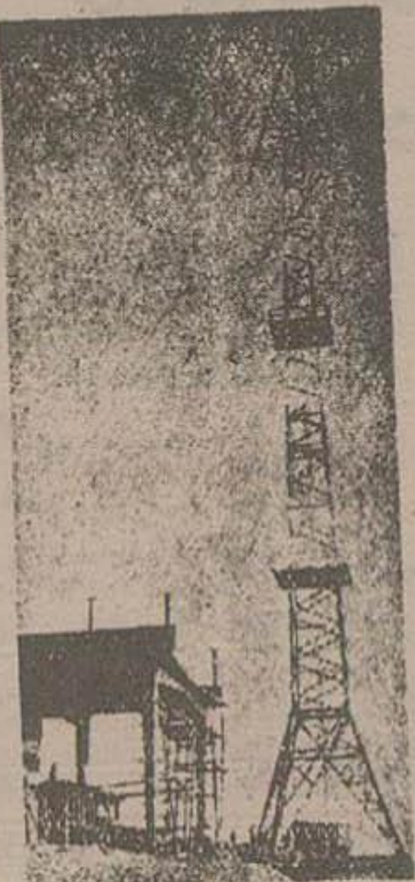
دکل و گوشه ای از ساختمان استودیو مرکزی
