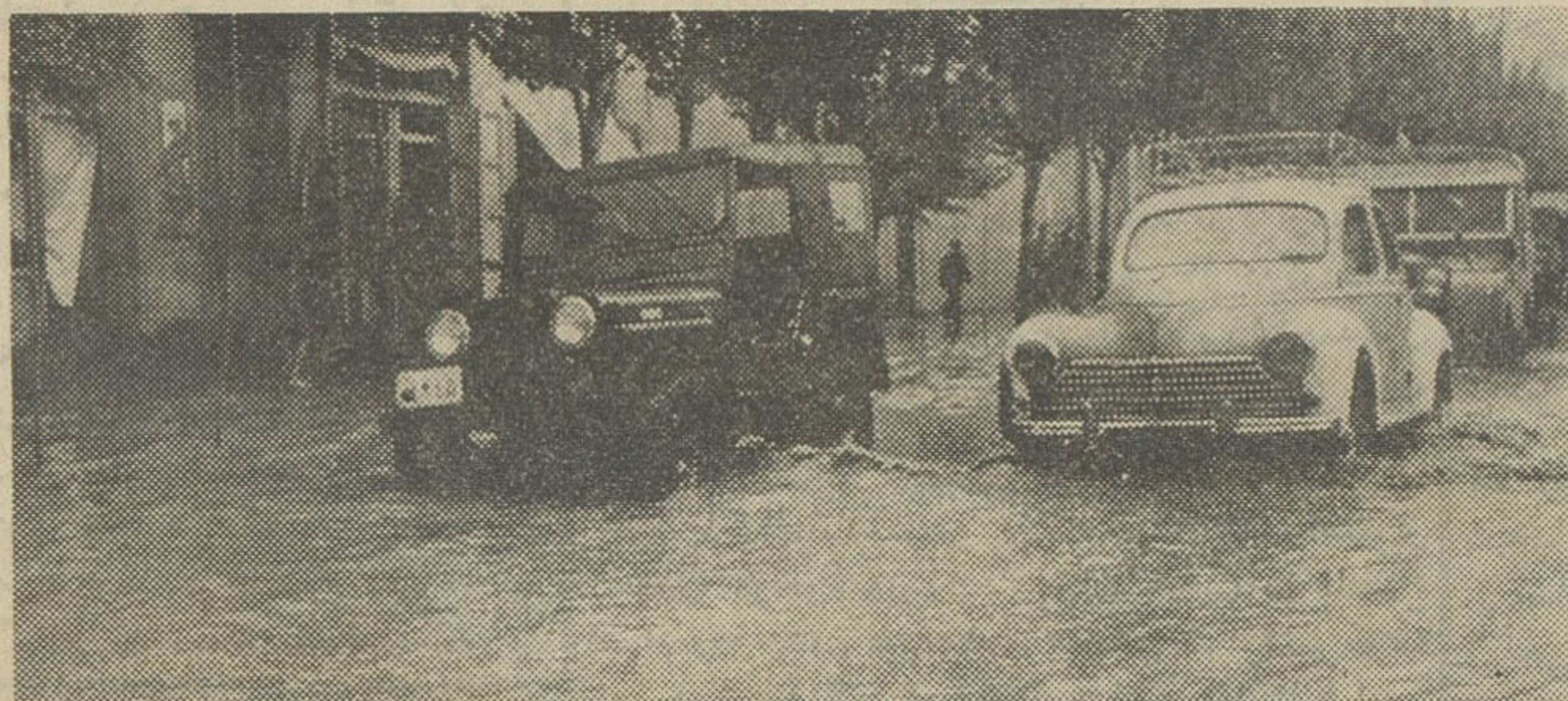
منظره ای از خیابان ساحلی خرمشهر که وسایط نقلیه در آن بر اثر هجوم سیل قادر بر حرکت نیستند و متوقف شده اند نیمه شب دیشب بر اثر بارندگیهای شدید :
