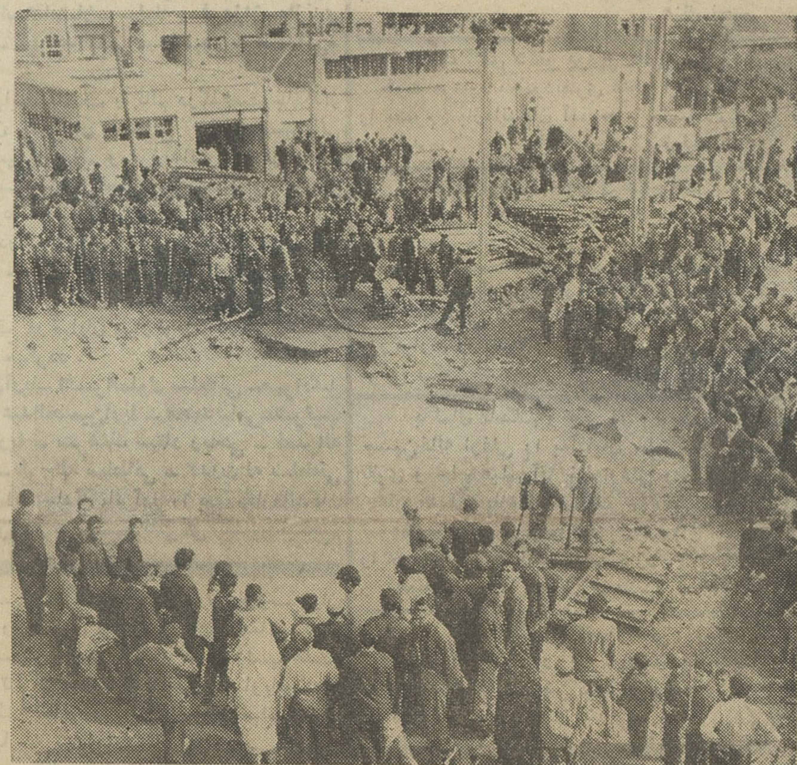
سیلاب در جلوی تونل آب نهر فیروزآباد جمع شده است و کارگران مشغول تخلیه کانال از آب هستند. جنازه کارگر مفروق نیز در همین نقطه بدست آمد
