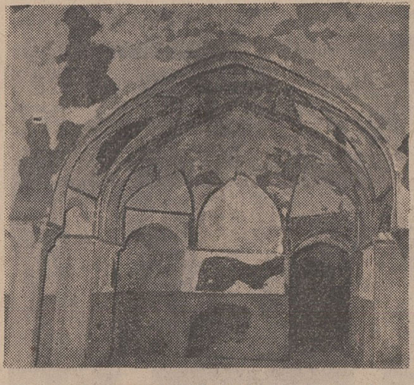
گرماخانه حمام «گنجعلیخان» که در دست تعمیر است .
