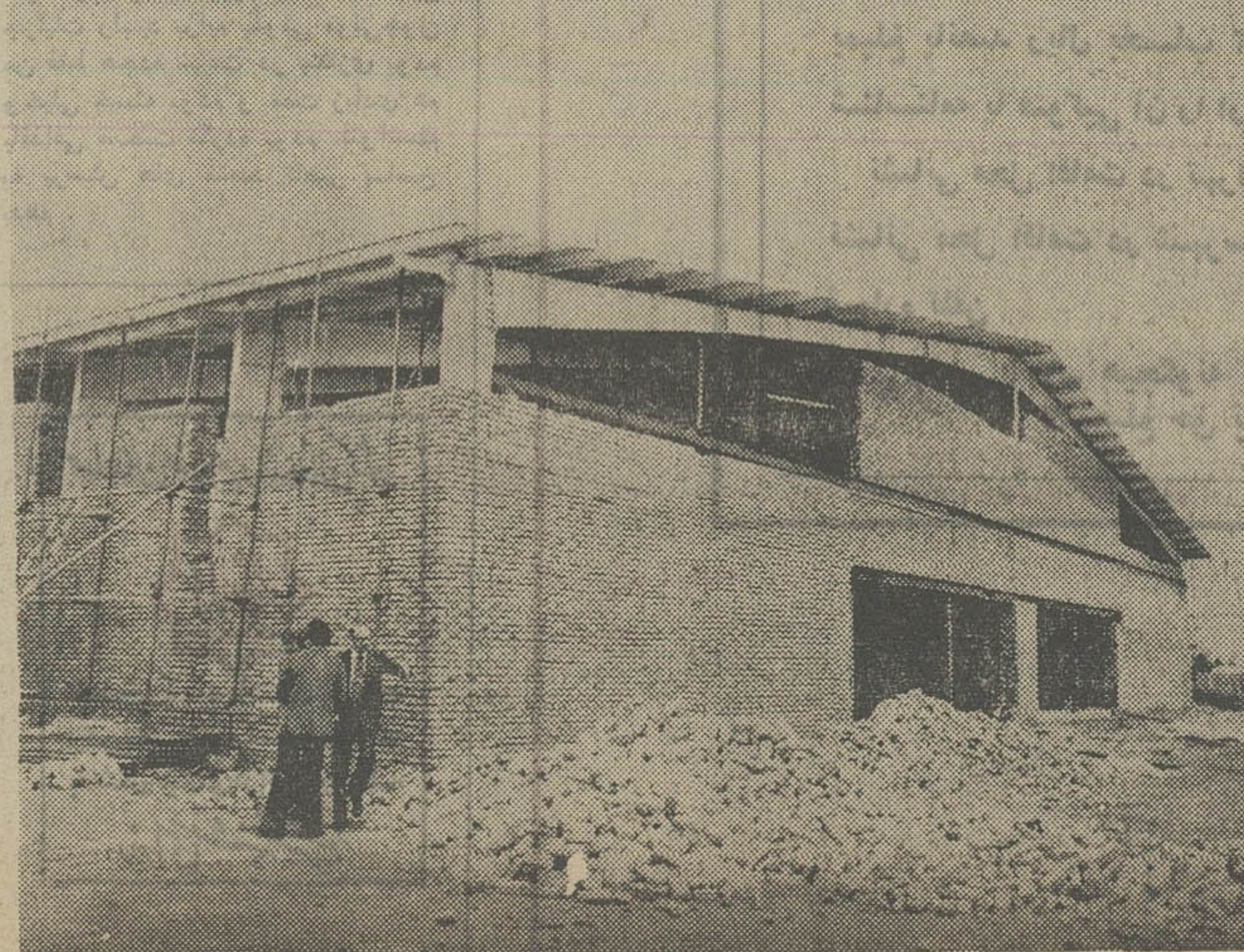
هوشنگ اربابی - رئیس هواپیمائی کل کشوری - و گزارشگر «اطلاعات» هنگام بازدید از عملیات ساختمانی جدید حجاج .. سالن ۱۰ هزار متر مربعی ساختمان
