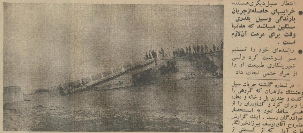
پل رودخانه «وازیوار» که بر اثر جریان سیل شکست و چند کامیون و یک وانت از شکستگی آن با موج سیل فرو افتادند
