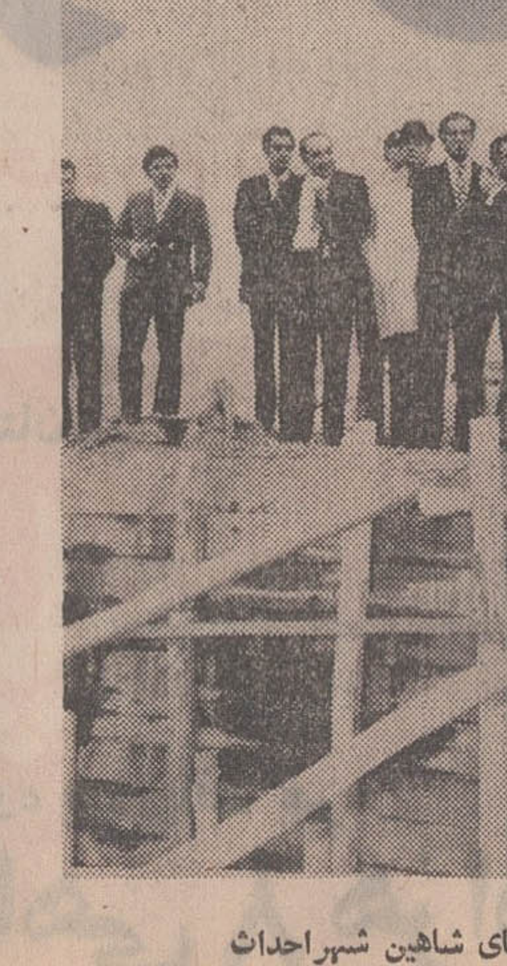
وزیر آبادانی و مسکن و سایر همراهمان از بل بزرگی که در یکی از خیابان های شاهین شهر احداث خواهد شد دیدن کردند.
