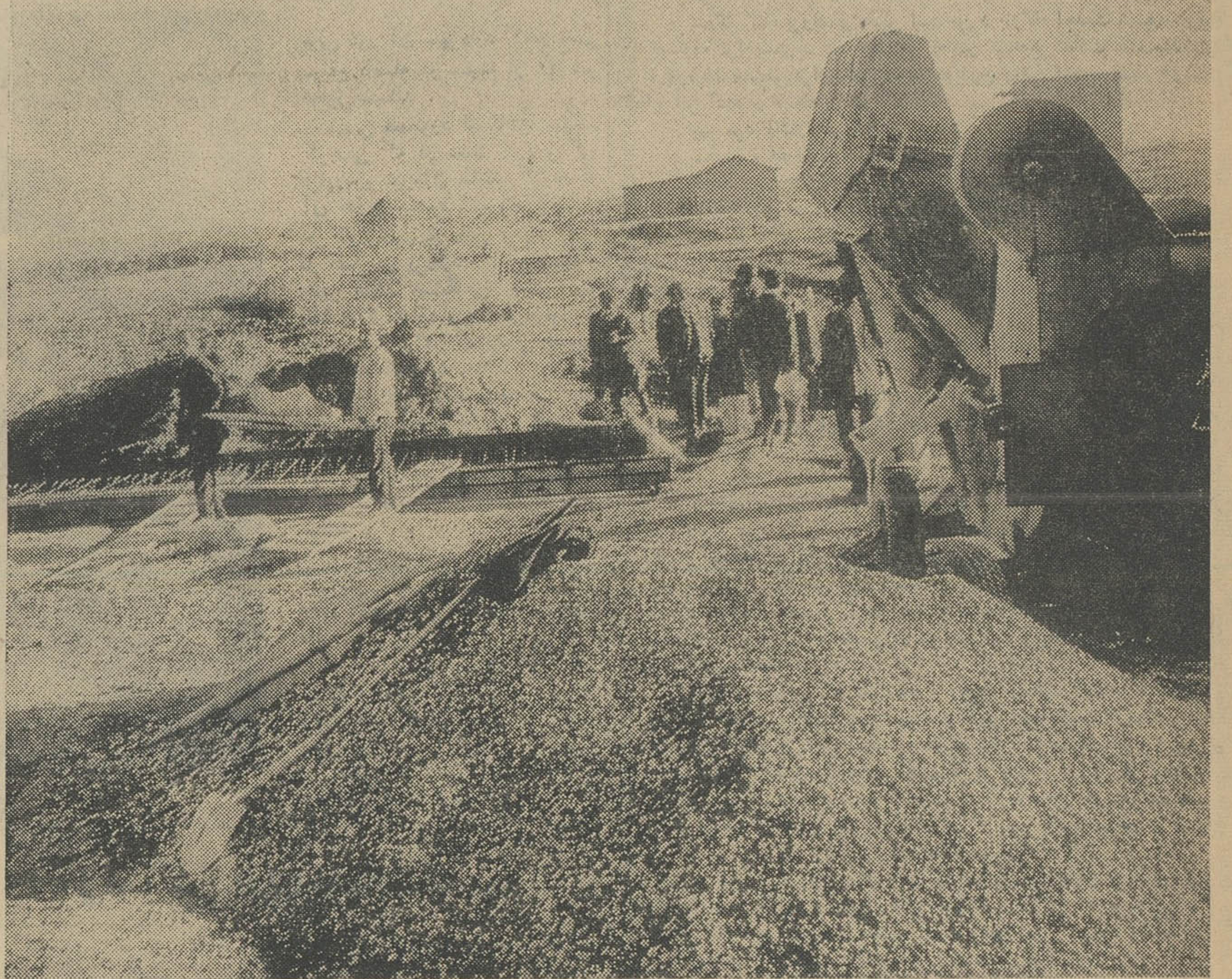
در بخش بم و نورماشیر و درکنار بیابان لوت شرکت های راهساز مشغول عملیات راهسازی هستند .
