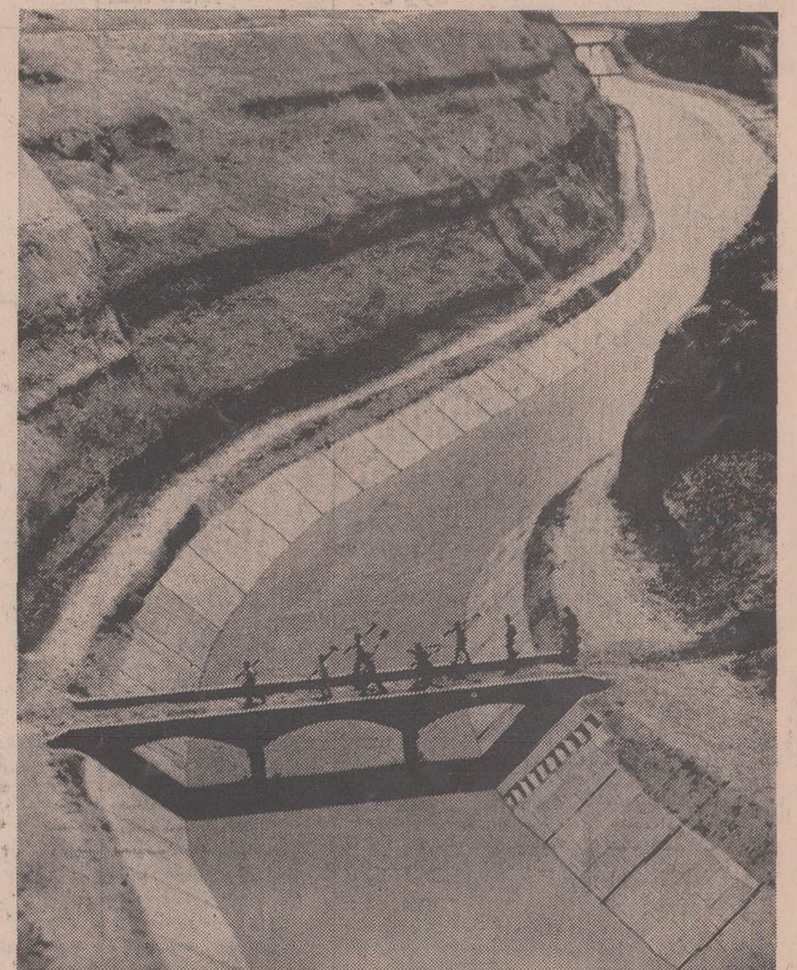
سیستم آبیاری در کتون‌ها
