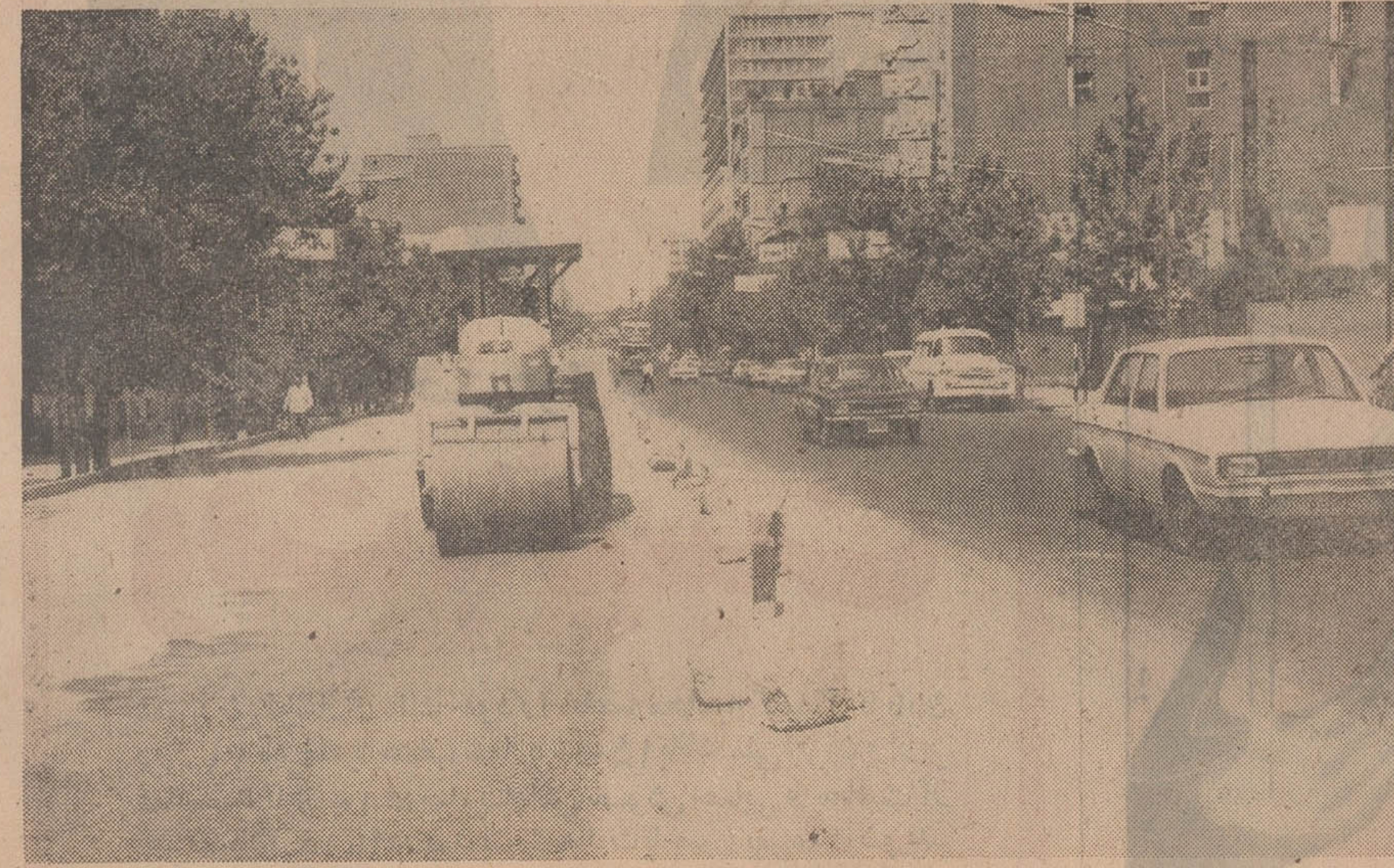
برای اسفالت خیابان تخت جمشید دقت کافی در مقاومت زیرسازی و نوع اسفالت بعمل آمده، زیرا که در مدت روزی بیش از ده هزار و در مدت سال چهار میلیون اتومبیل از روی اسفالت خیابان عبور میکنند.
