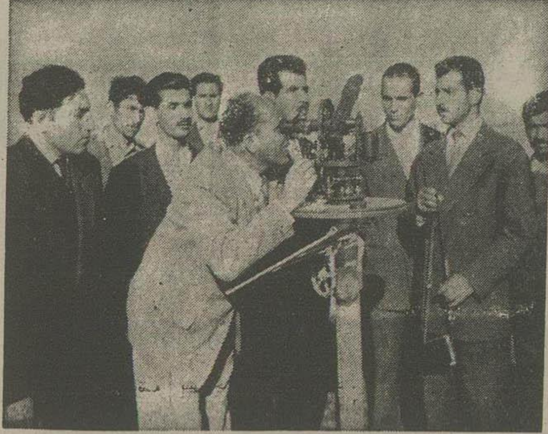
خط سیم افقی و عمودی بالون درحین پرواز بوسیله دستگاه تئودولیت که یکنوع تلسکوپ ک کوچک میباشد مورد مطالعه میگردد و پنج در صد آنچه را که با قمر رادیوسوند و دوازده بالون هواشناسی داخلی یک دیزل است آتوقت دقت مصنوعی انجام میدهند انجام می دهند. اهمیت کار با این دستگاه هاروشن میشود و از مجموع آن وضع باد در ارتفاعات بالای جو را تا ۱۳ کیلو - بیش از پنجاه در صد از توسعه ایستگاههای جوی بالا در ایران در زمان تری و وضع رطوبت و فشار و تشکیل اداره کل هوا شناسی انجام حرارت و ارتفاع را تا ۲۶ کیلومتری شده پیشرفت های این اداره در نظر سطح زمین تعیین مینمایند.
