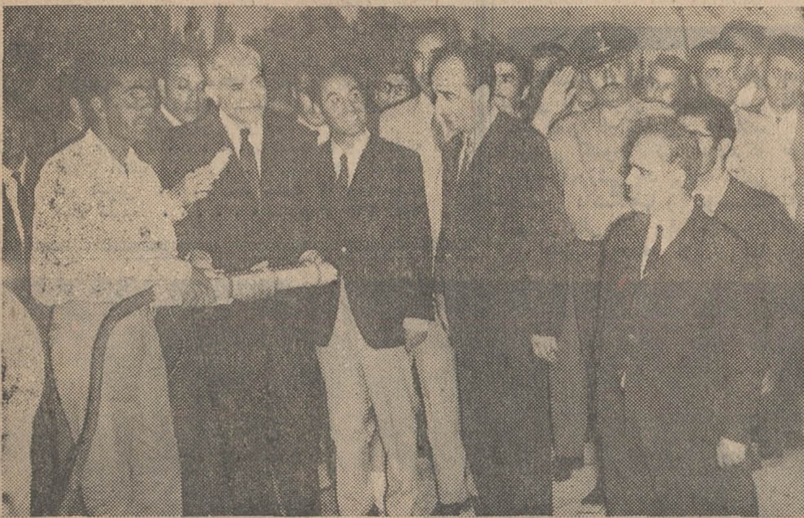
آقای استاندار هنگام فشار دادن دکمه جرقه‌گیر برای شروع ساختمان هتل بزرگ ۱۲۰ اتاقی
