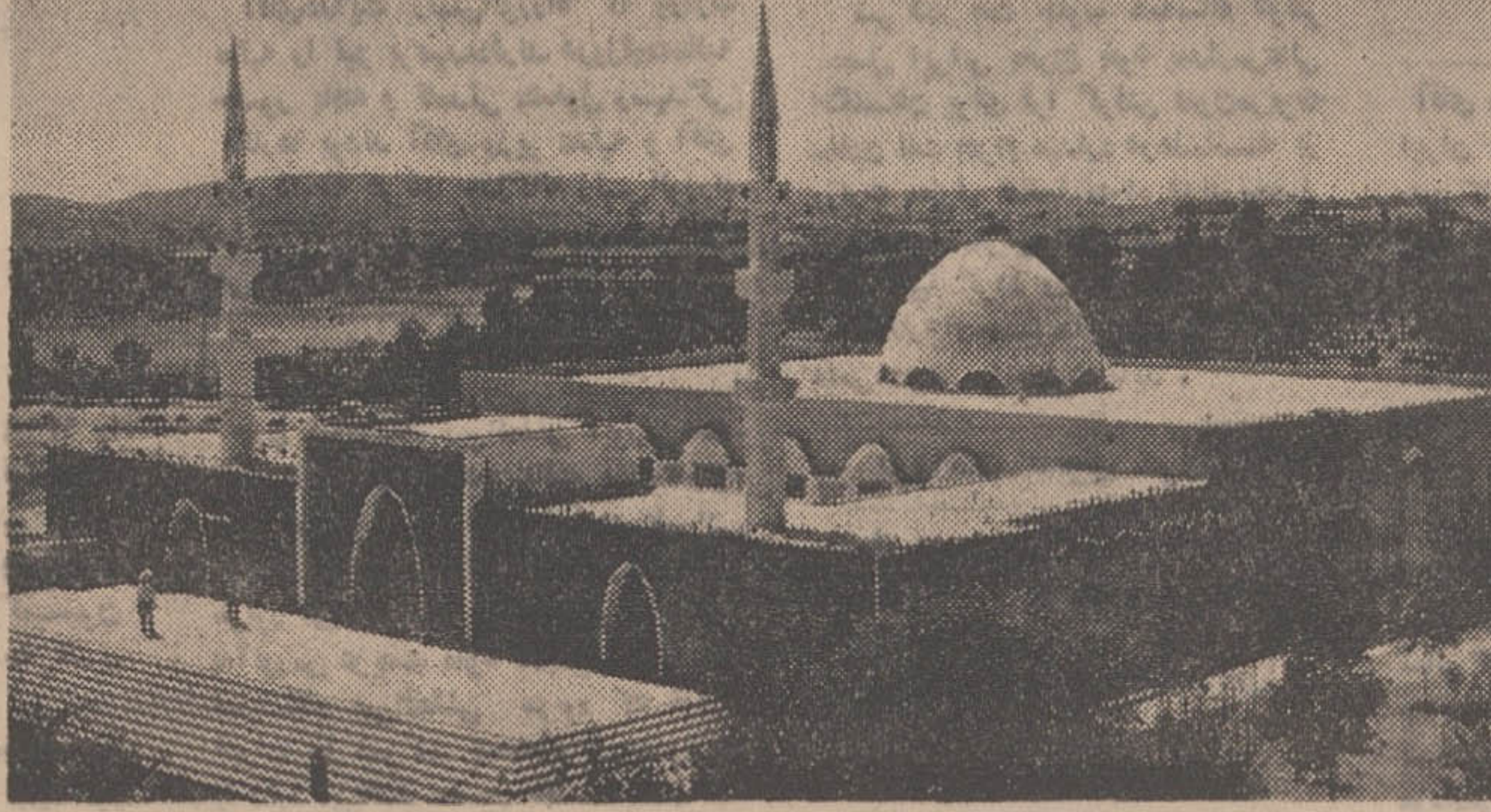
مسجد بزرگ اسلام آباد نمونه ای از ترکیب هنر معماری بومی با تکنیک های مدرن ساختمانی است.
