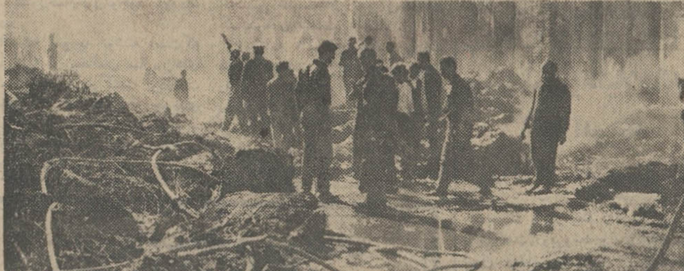
گوشه‌ای از کارخانه نساجی سمنان پس از اطفاء حریق بطوریکه مشاهده میشود قسمت عمده کارخانه سوخته و بیم ریخته است
