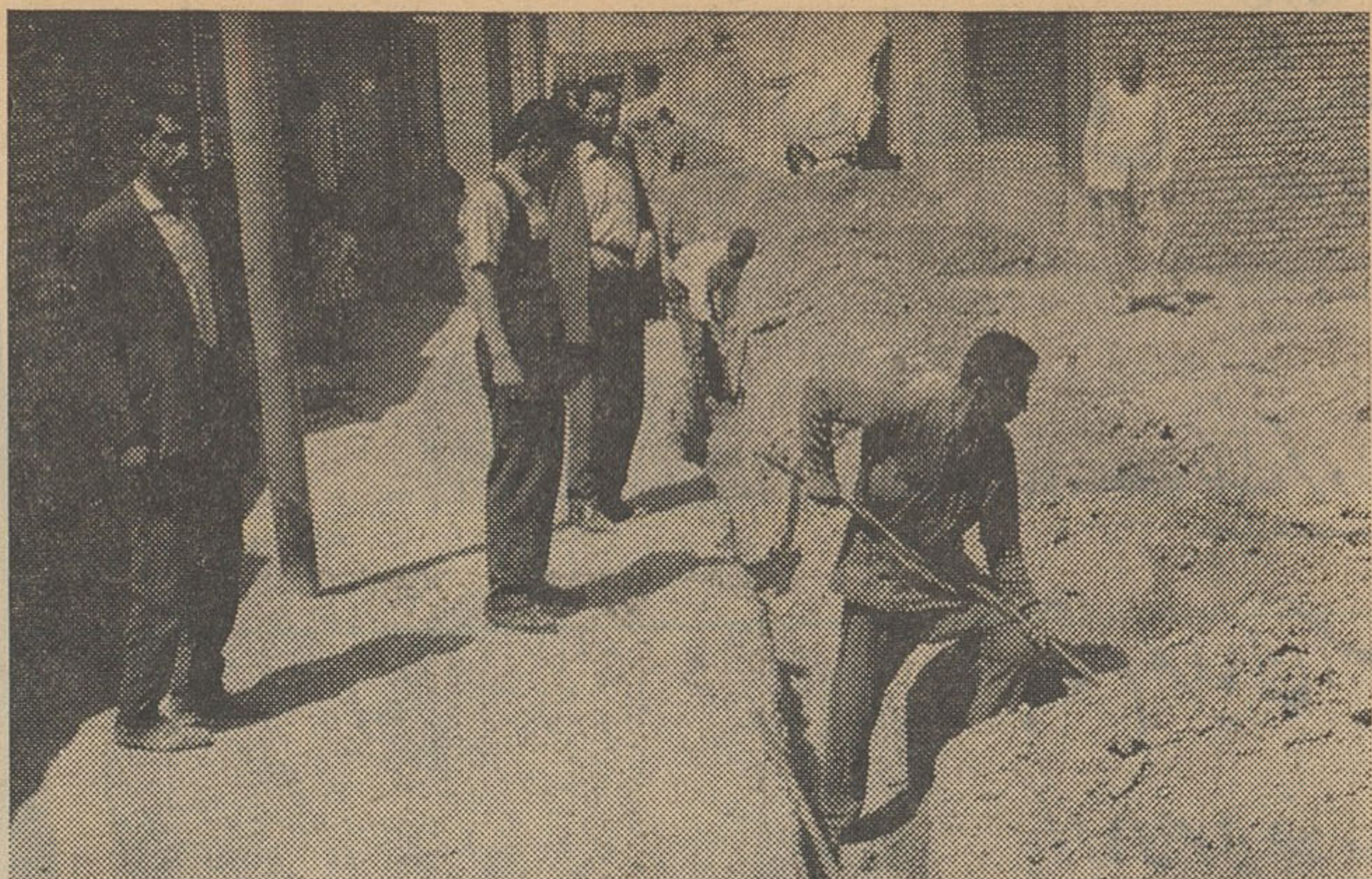
در این عکس مردم کوی خزانه هنگام حفر مسیر لوله کشی دیده میشوند
