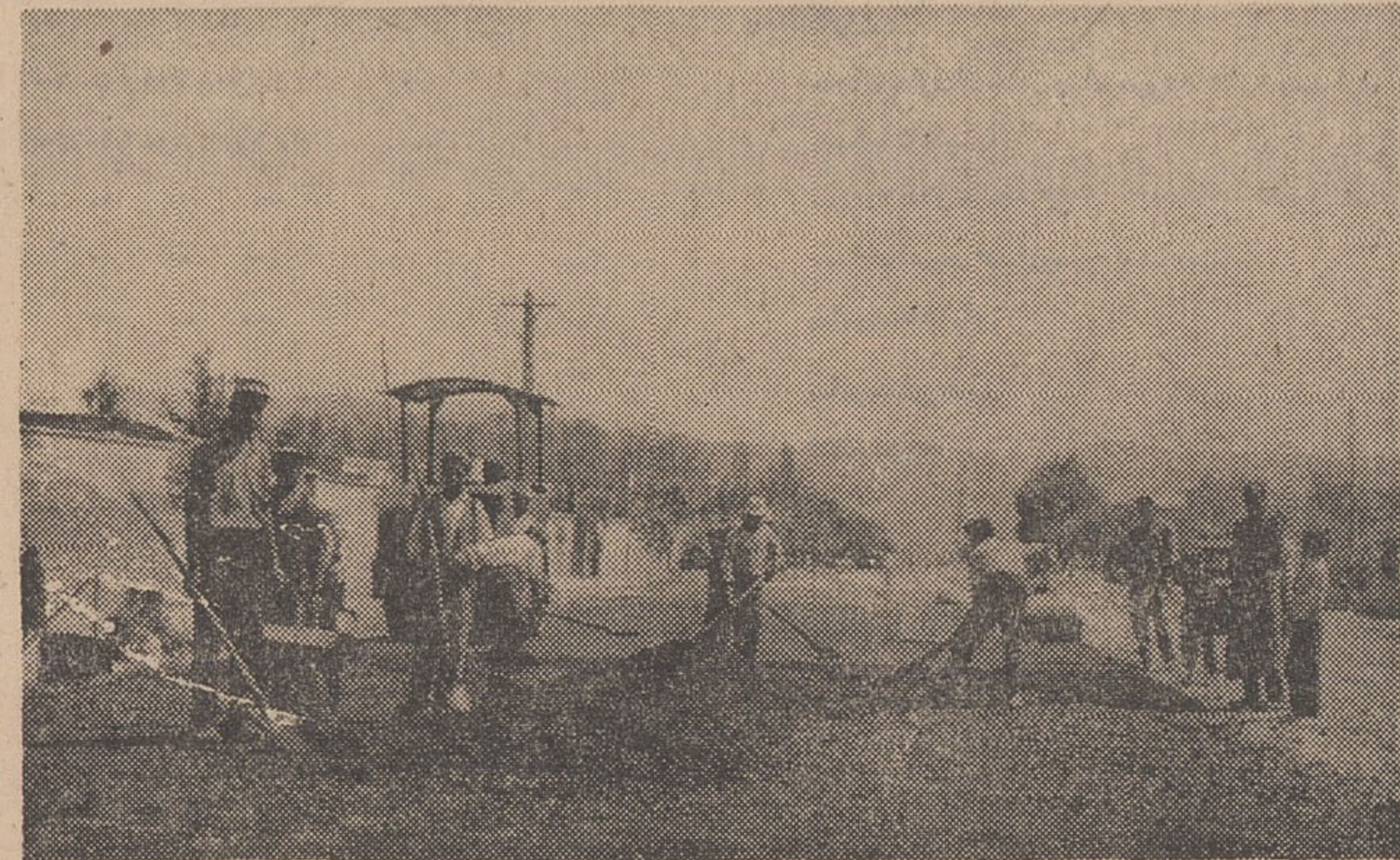
کارگران در حال قیرویزی خیابان هستند
