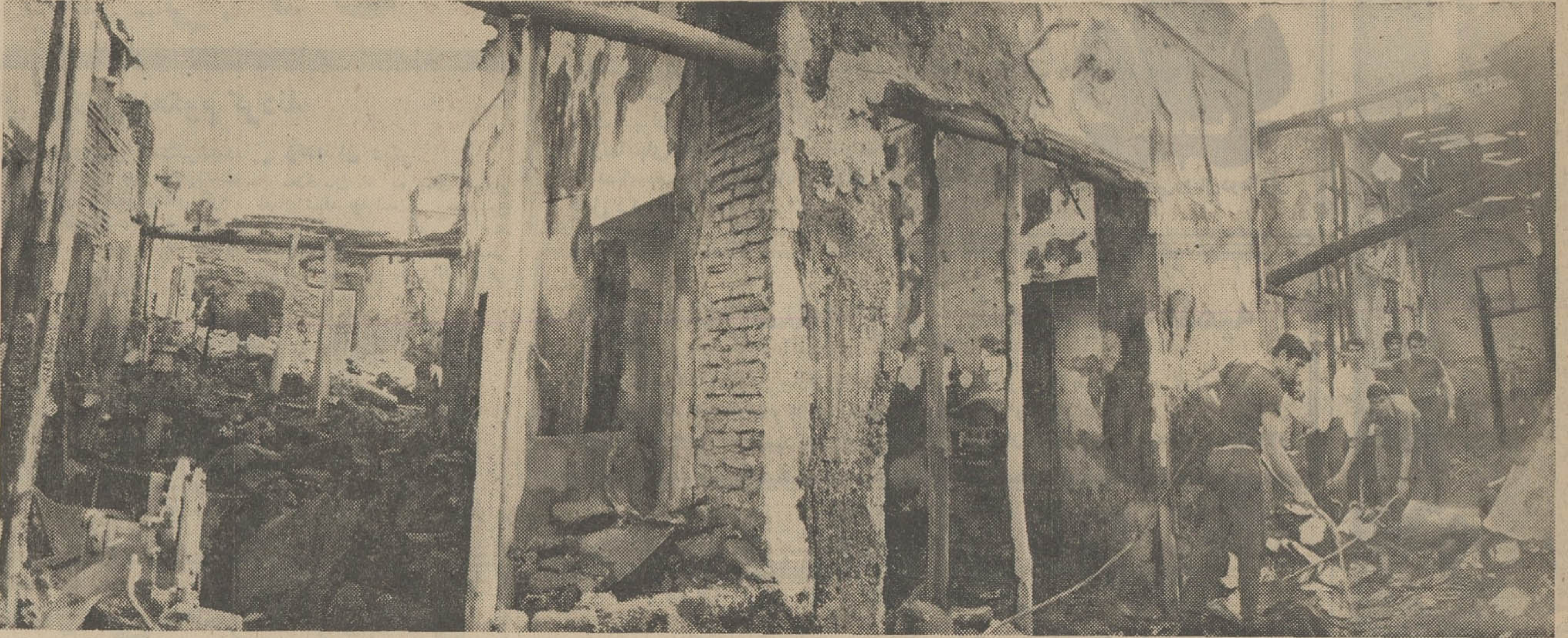
حریق دیروز، کوچه کرامت واقع در خیابان لاله زار به این صورت در آرد. مغازه ها و خانه ها در خیابان لاله زار با این که ظاهری زیبا دارند ولی غالب آنها استحکام چندانی ندارند و گسترش حریق دیروز به خاطر این بود که سقف مغازه ها همیچنانکه در عکس می بینید از چوب ساخته شده بود.
