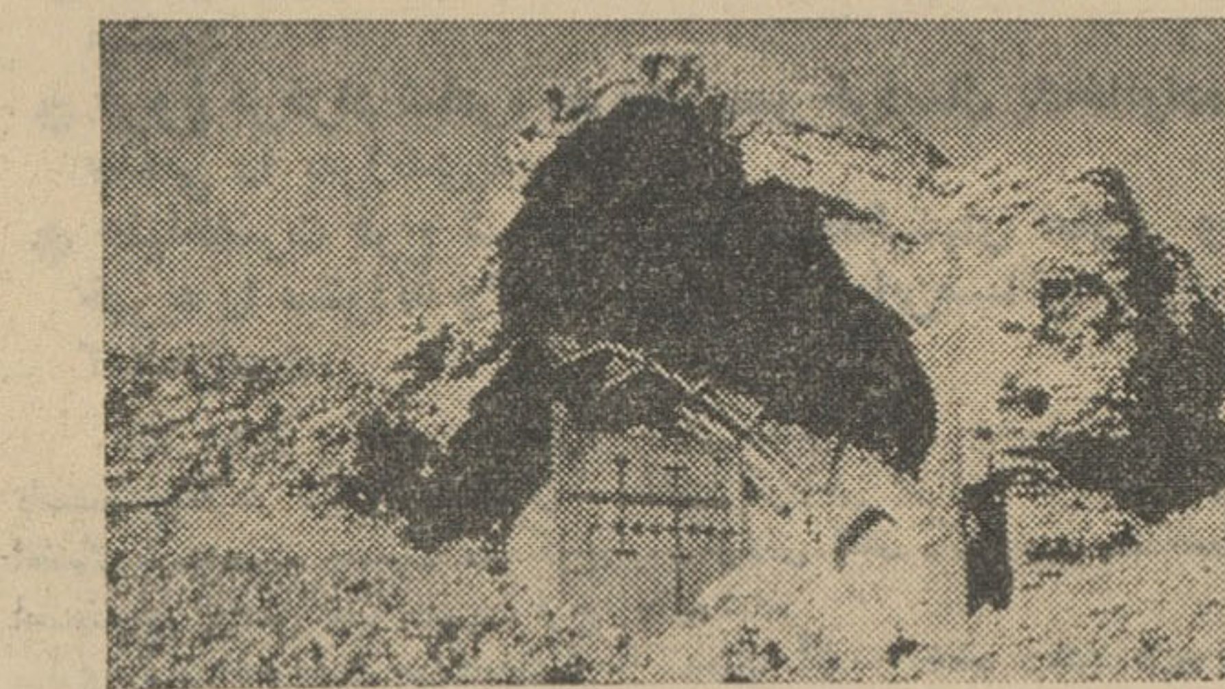
انچه زلزله در قریه حصار بجای نذاارد...
