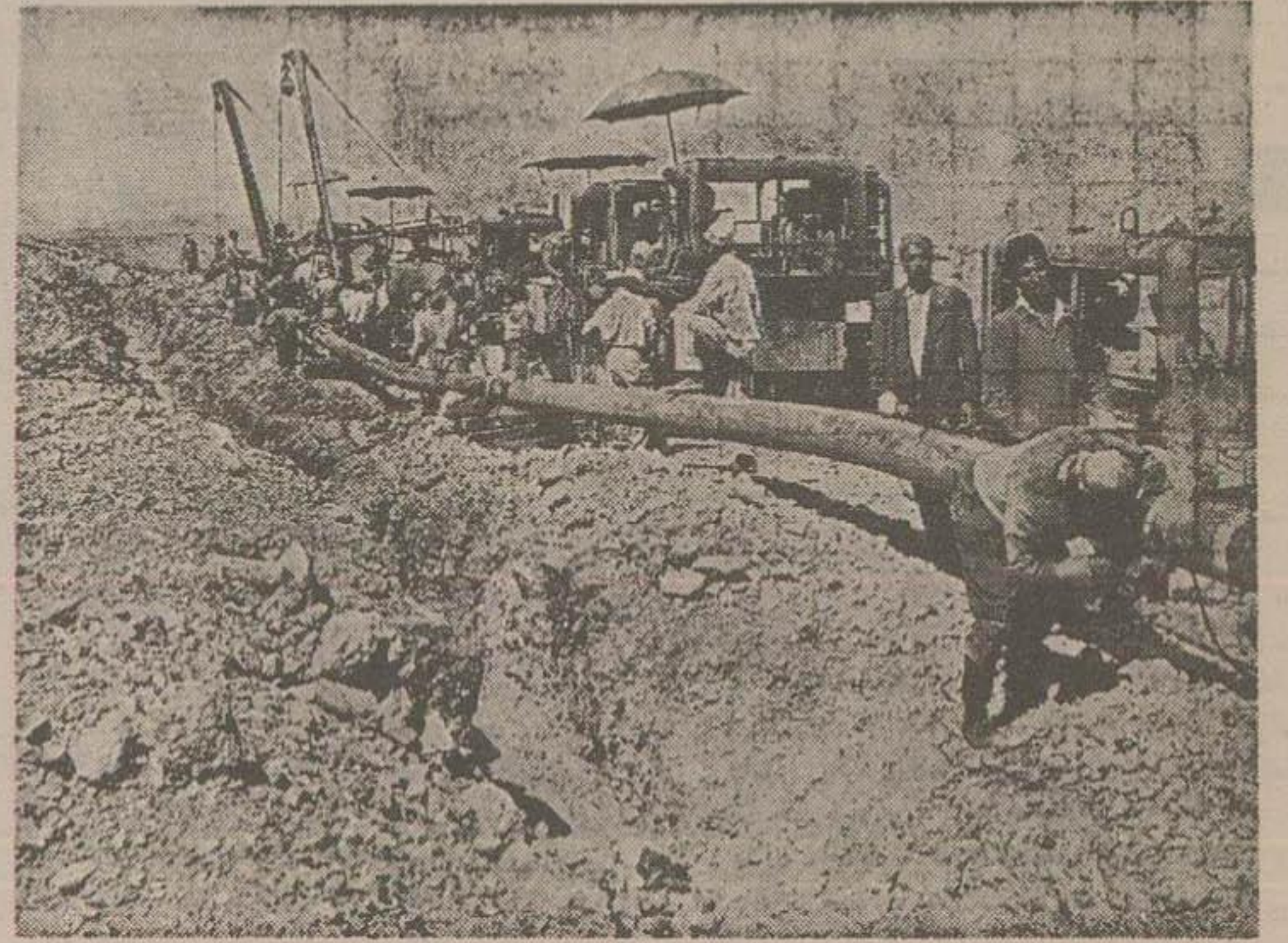
منظره‌ای از ساختمان لوله نفت تهران-آبادان
