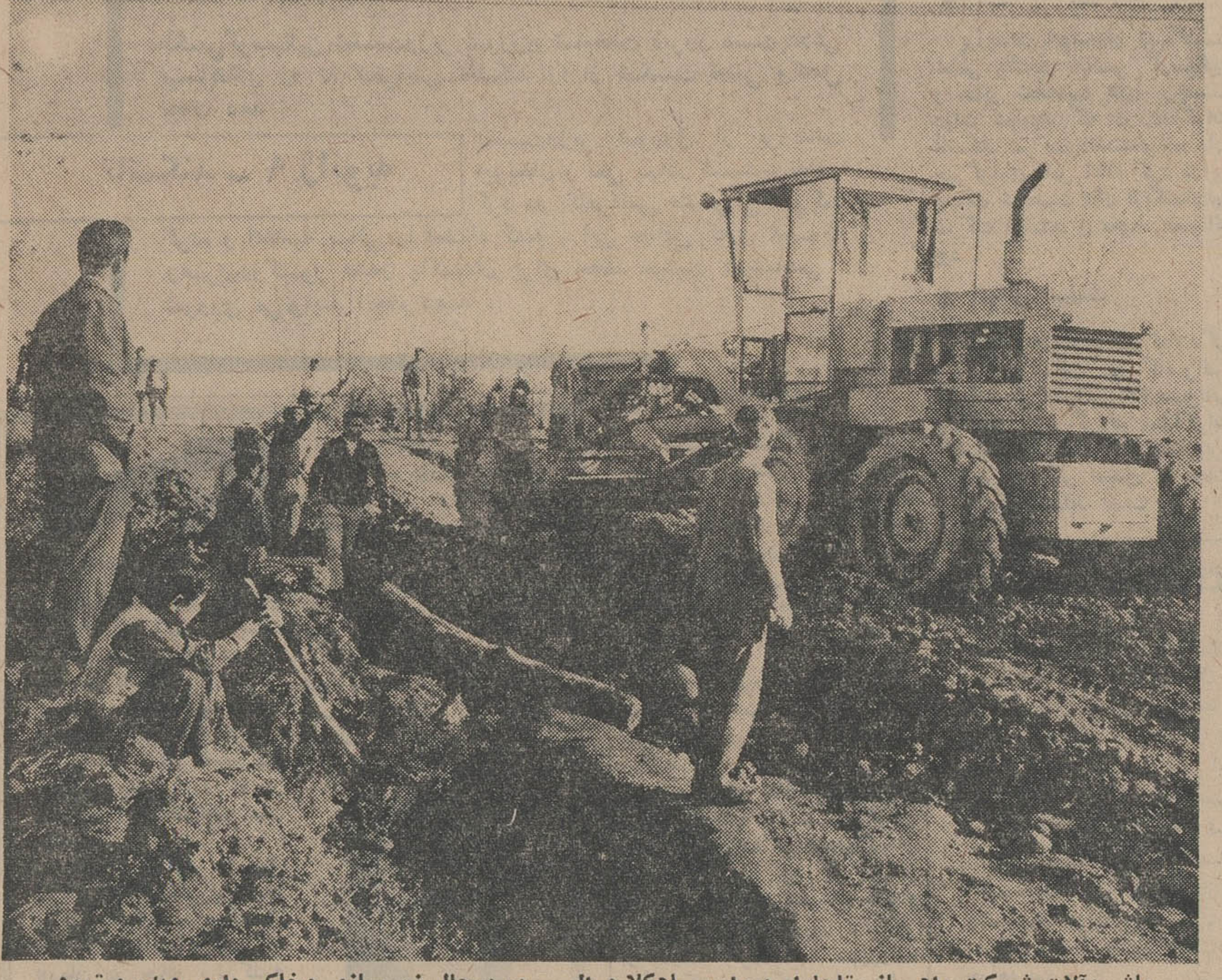
ماشین آلات شرکت راهساز «تاجارا» در راه سیاهکلا و ایس ده در حال زیرسازی و خاکبرداری دیده میشود
